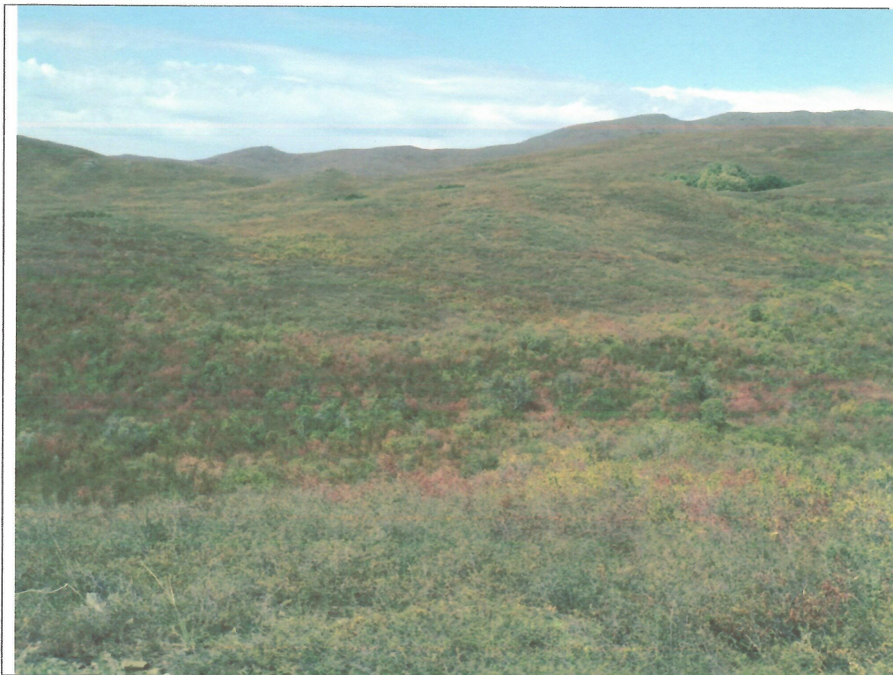
Фото 6. Общий вид данного объекта: «Золотоизвлекательная фабрика кучного выщелачивания производительностью 142 м 3 /час, в Кокпектинском районе Восточно-Казахстанской области»
