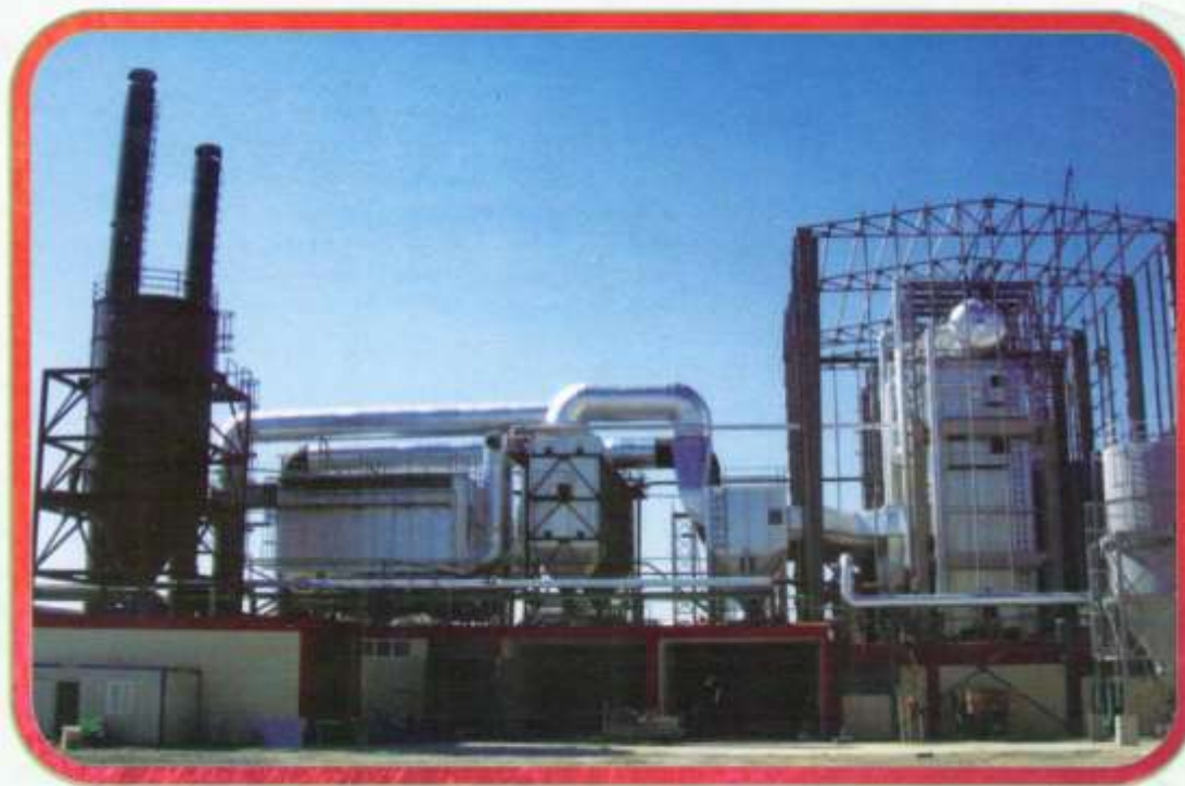
Tat Salça Harmanova Tesisleri / *anliurfa, 2x 50 ton/h 16 atü
