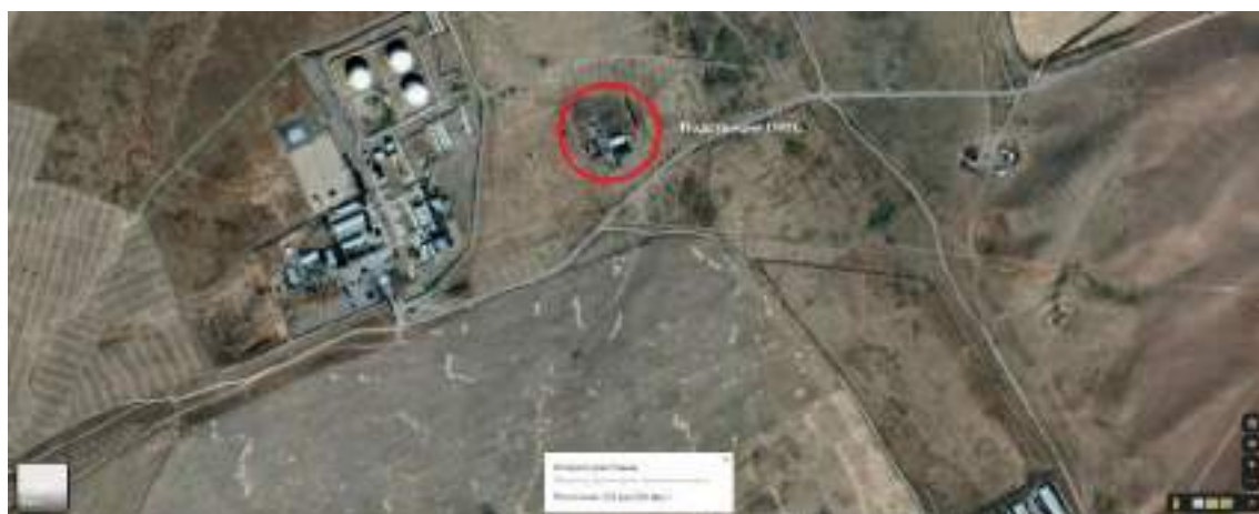
Рис. 11.5. Подстанция ПС «ГНПС»
