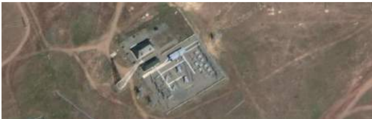
Рис. 6.15. Подстанция ПС «Куянды Южная»
