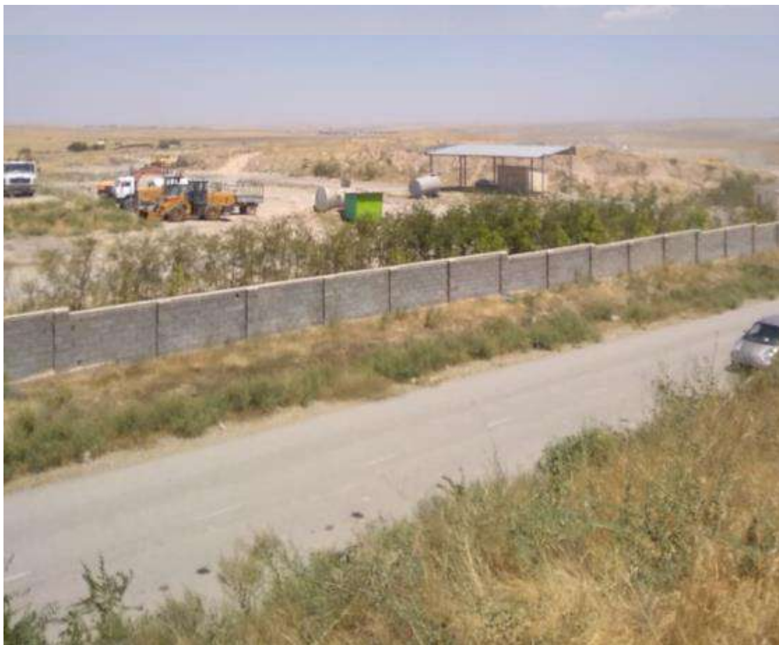
Рис. 11.13. Фото с объекта
