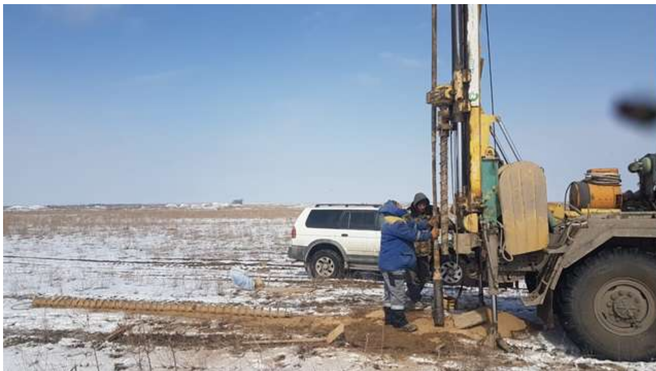
Рисунок 1.2. Буровые работы на участке
