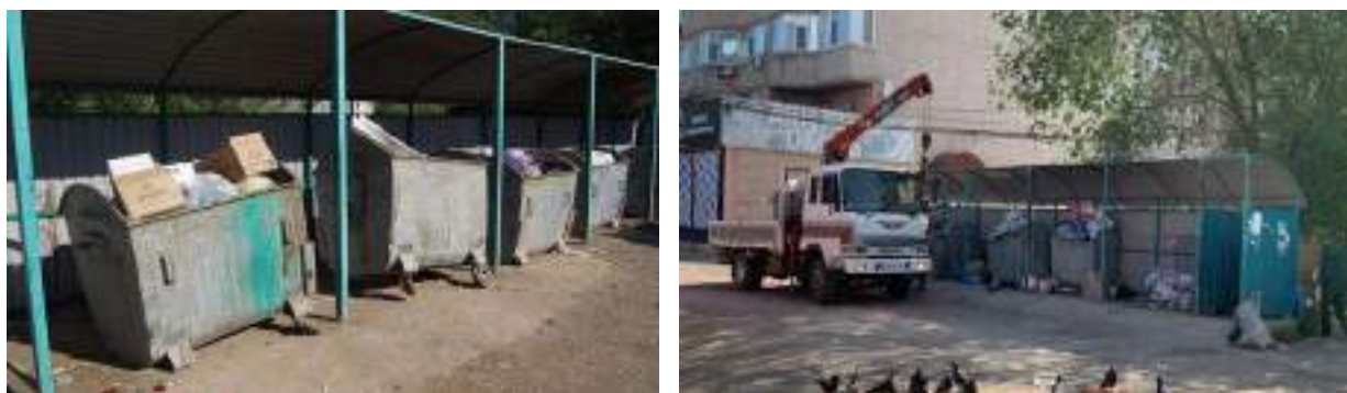
Рис. 8.2. Состояние площадки, контейнеров для сбора ТБО
