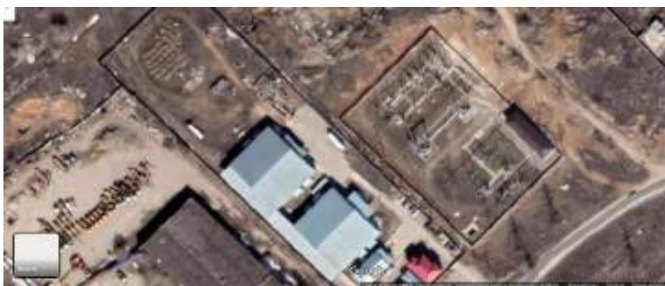
Рис. 8.12. ПС 110/35/10 кВ «Западная»
