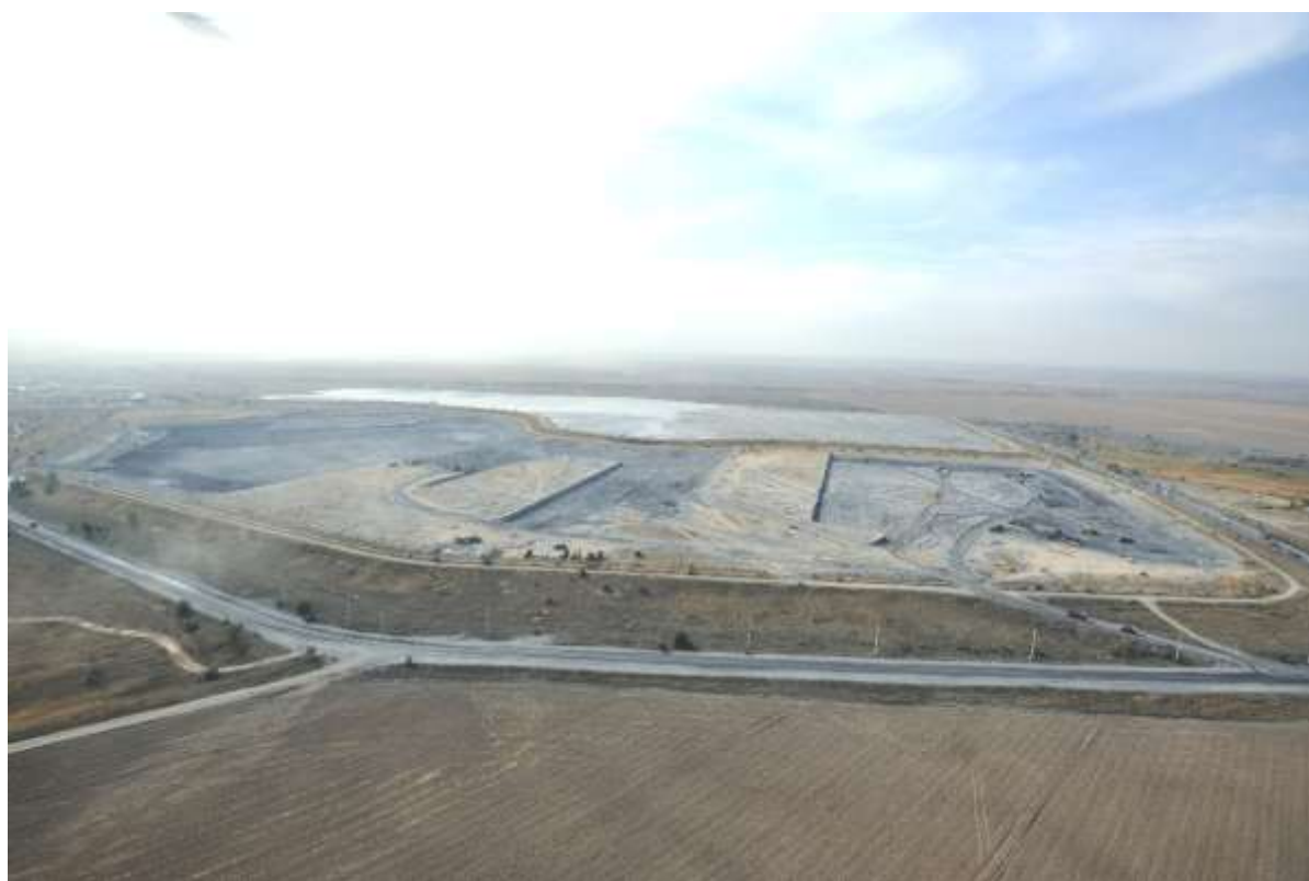
Рисунок 1.4. Общий вид золоотвала ТЭЦ-2
