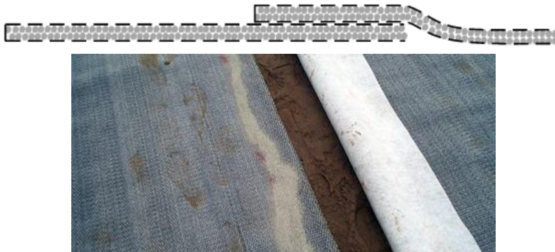
Рисунок 2 – Способ укладки бентонитовых матов с герметизацией нахлеста бентогранулами
