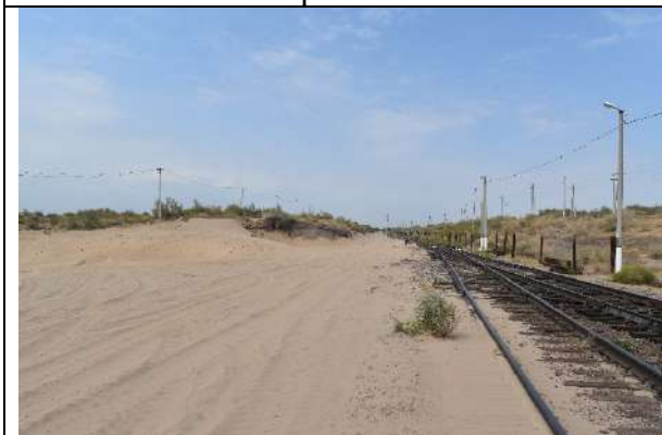
Фото 9 - Участок Перегон Иинтал-Алтынколь. Промежуточное фото. Вид на северо-восток
