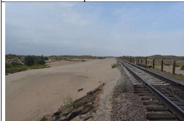
Фото 11 - Участок Перегон Иинтал-Алтынколь. Промежуточное фото. Вид на северо-восток
