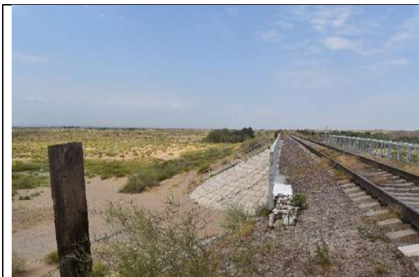
Фото 7 - Участок Перегон Иинтал-Алтынколь. Промежуточное фото. Вид на северо-восток
