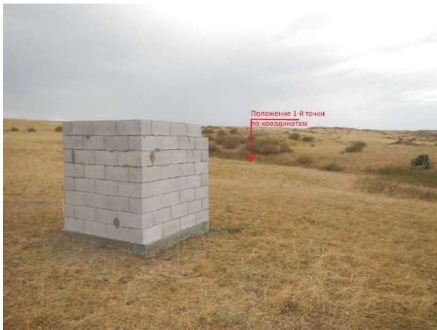
Фото 11.3. Строящийся фундамент (площадку) под размещение вышки сотовой связи
