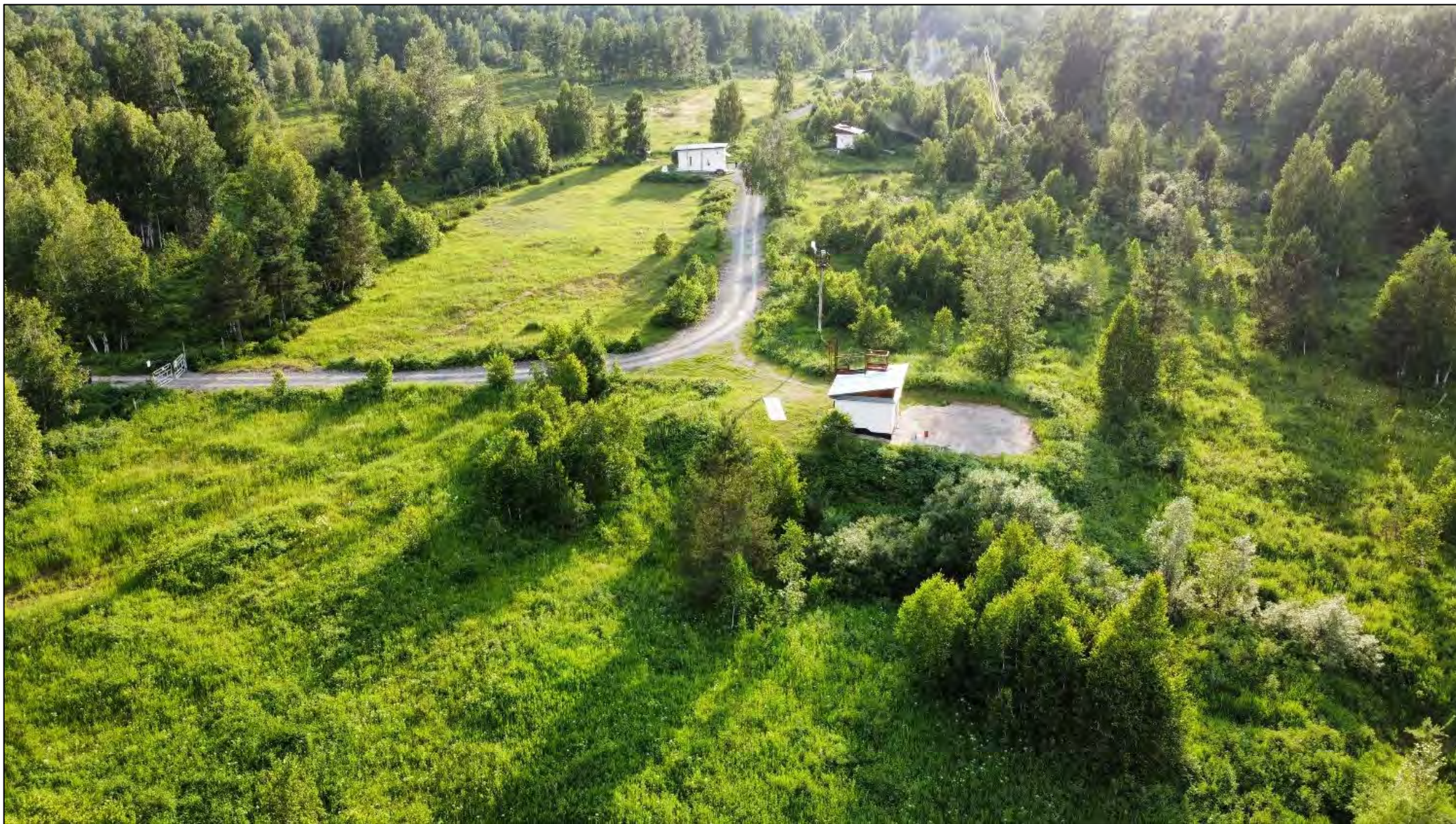
Рисунок 1.12. Общий вид на промплощадку Хамирского водозабора
