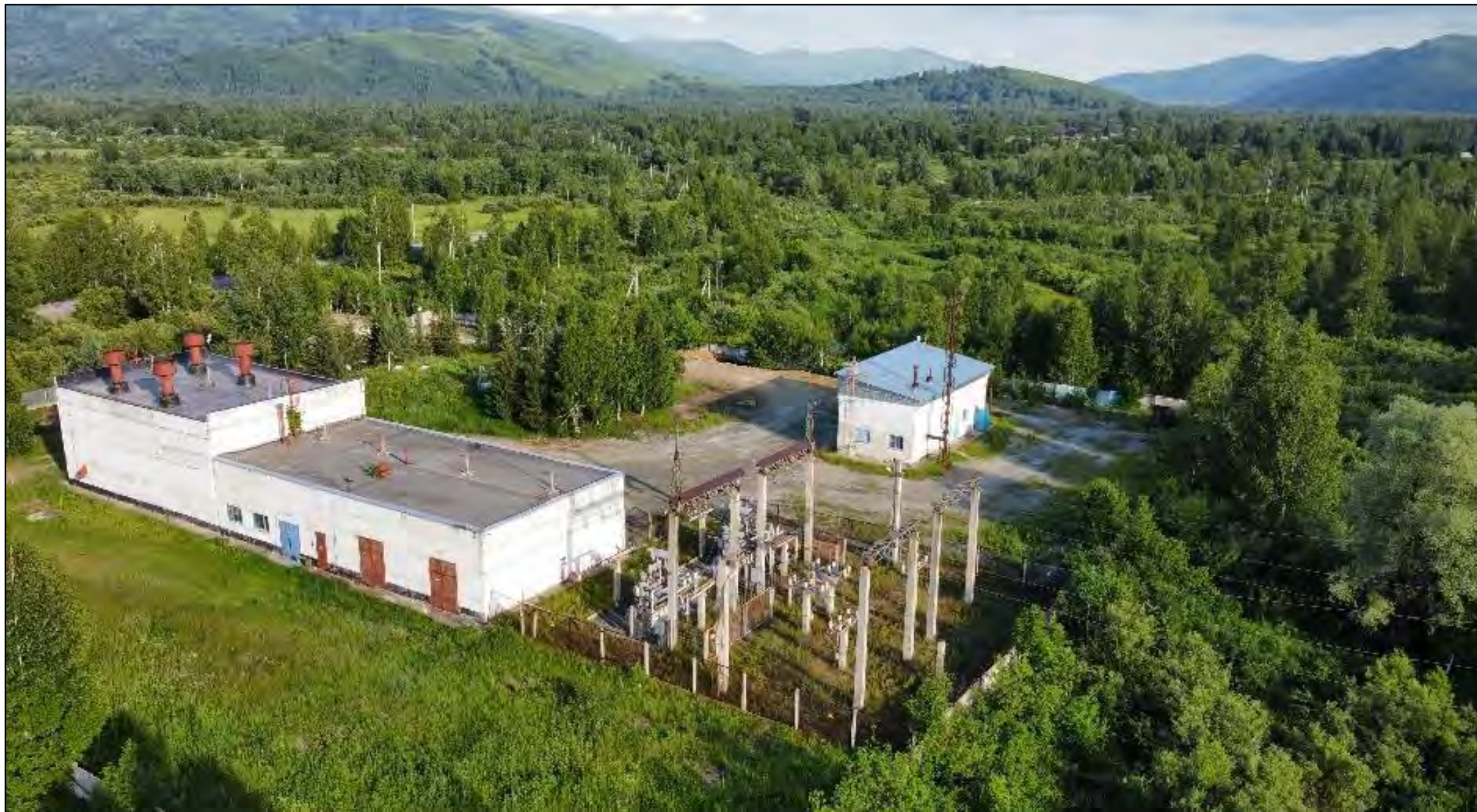
Рисунок 1.13. Общий вид на промплощадку насосной станции 2 подъема Хамирского водозабора
