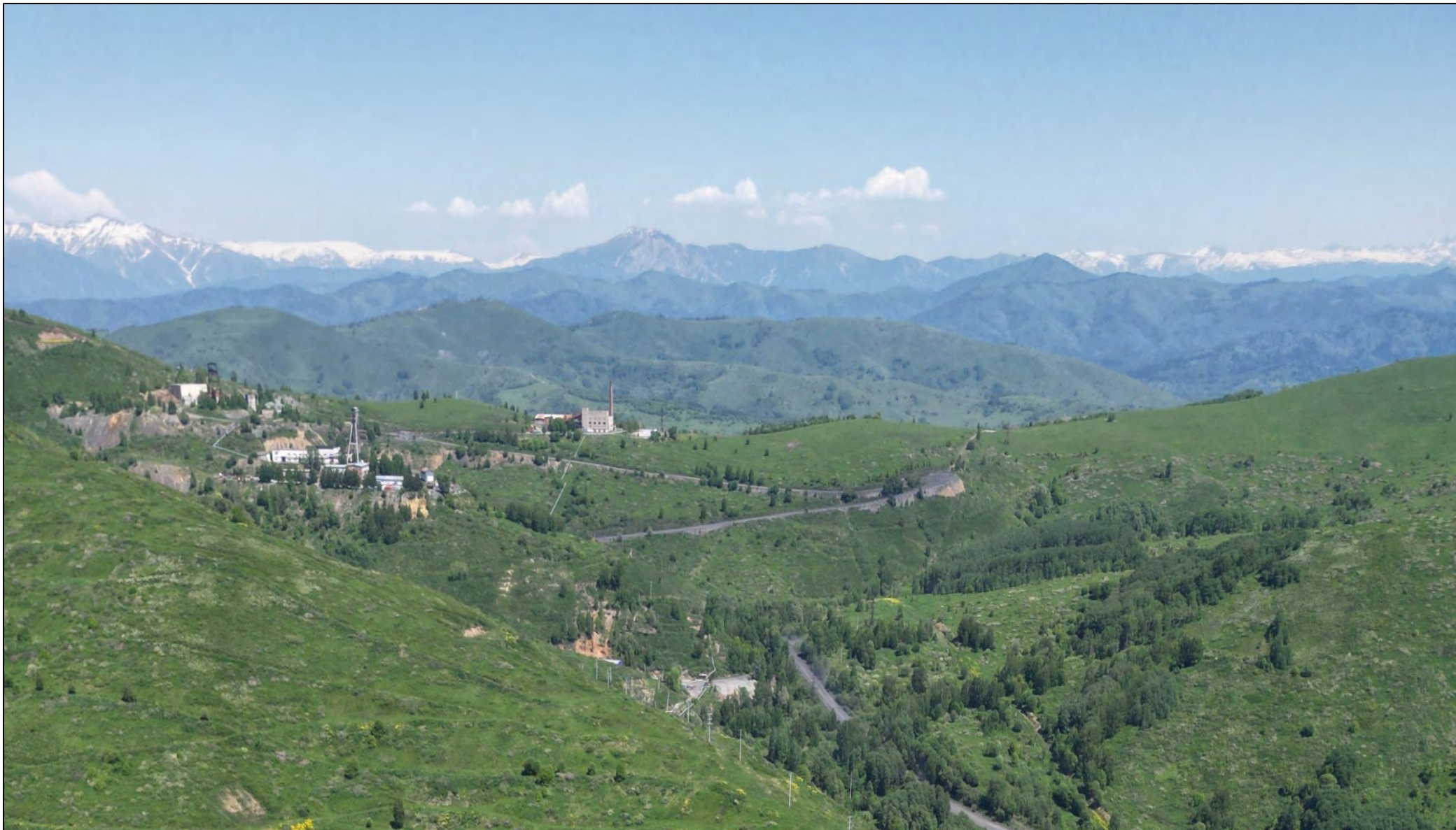
Рисунок 1.10. Общий вид на промплощадку шахт «Вентиляционная» и «Воздуховыдающая»
