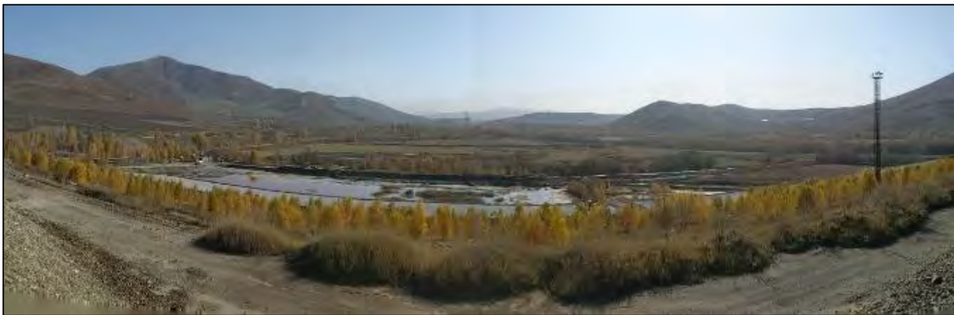
Рисунок 1.8. Пруды-отстойники Нового хвостохранилища обогатительной фабрики
