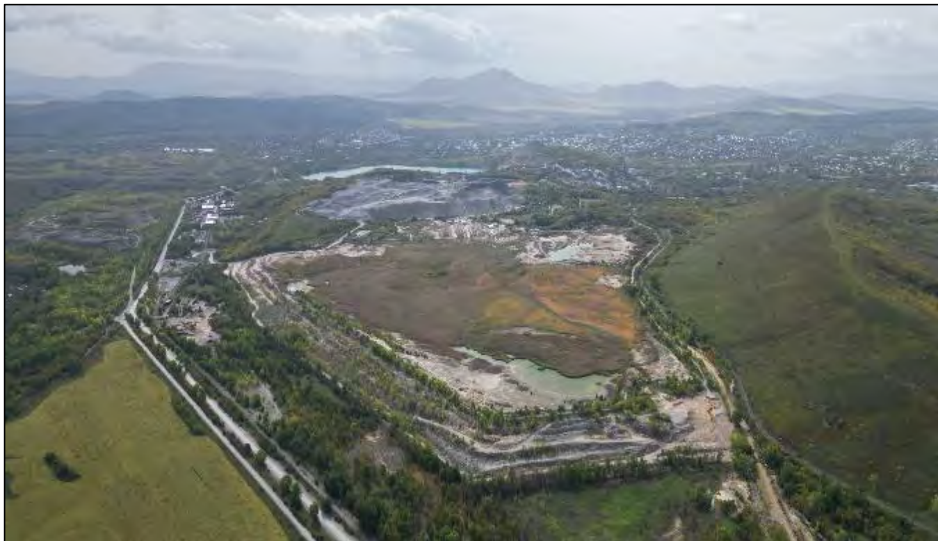
Рисунок 4.7. Обзорный вид на ландшафты в районе Старого хвостохранилища
