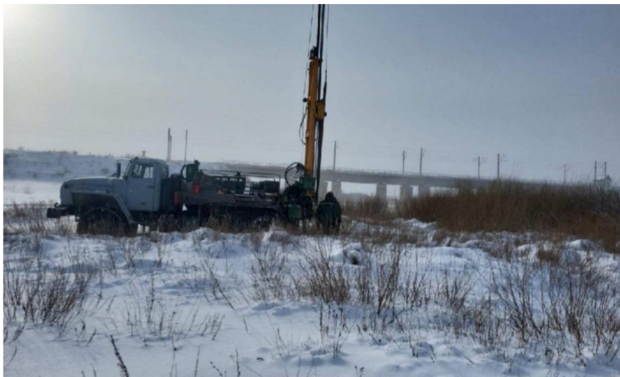
Фото 4.1. Геологические работы от моста 560 м, от речки Кылшакты -50м
