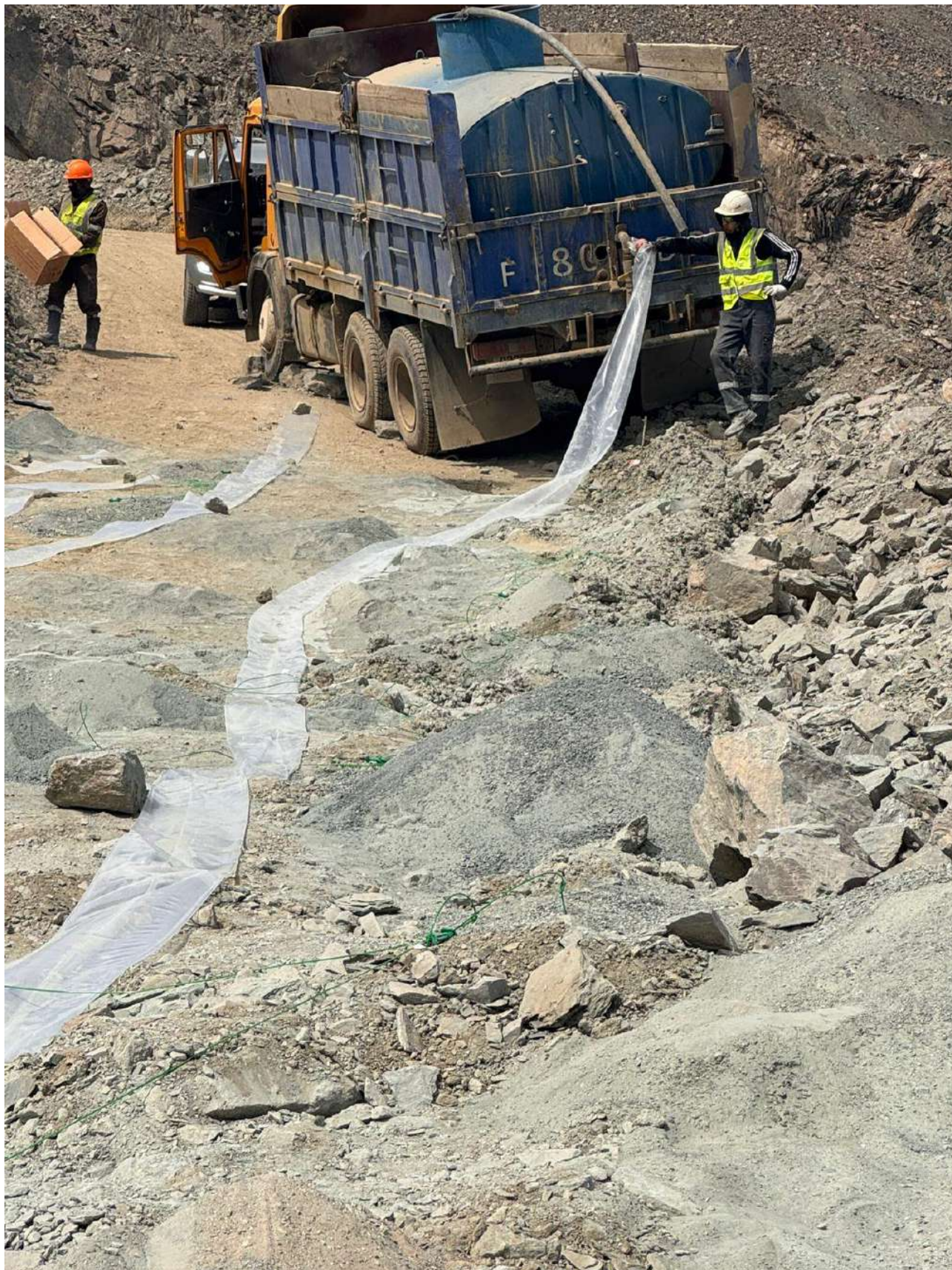
Осуществление гидрозабойки при проведении буровзрывных работ.
