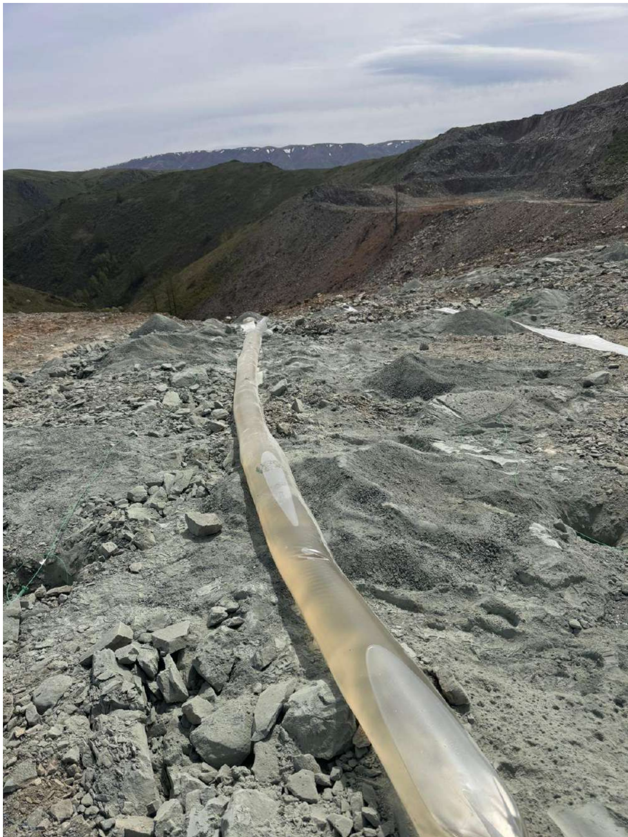
Осуществление гидрозабойки при проведении буровзрывных работ.
