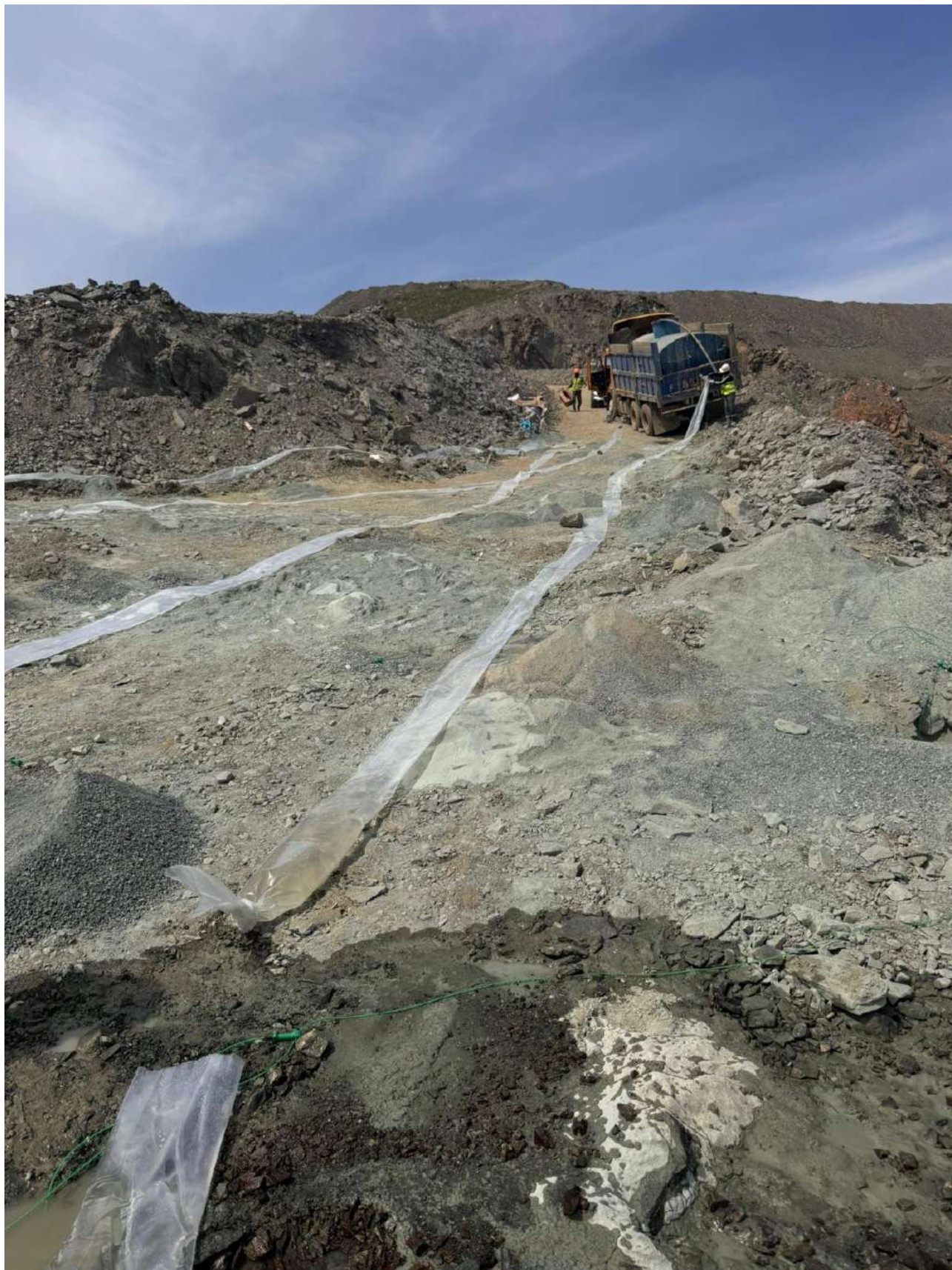
Осуществление гидрозабойки при проведении буровзрывных работ.
