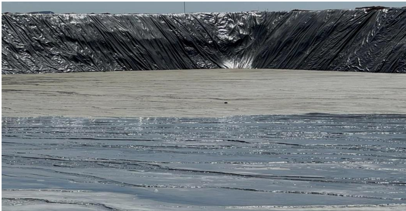
Фото 8. Вид на чашу хвостохранилища
