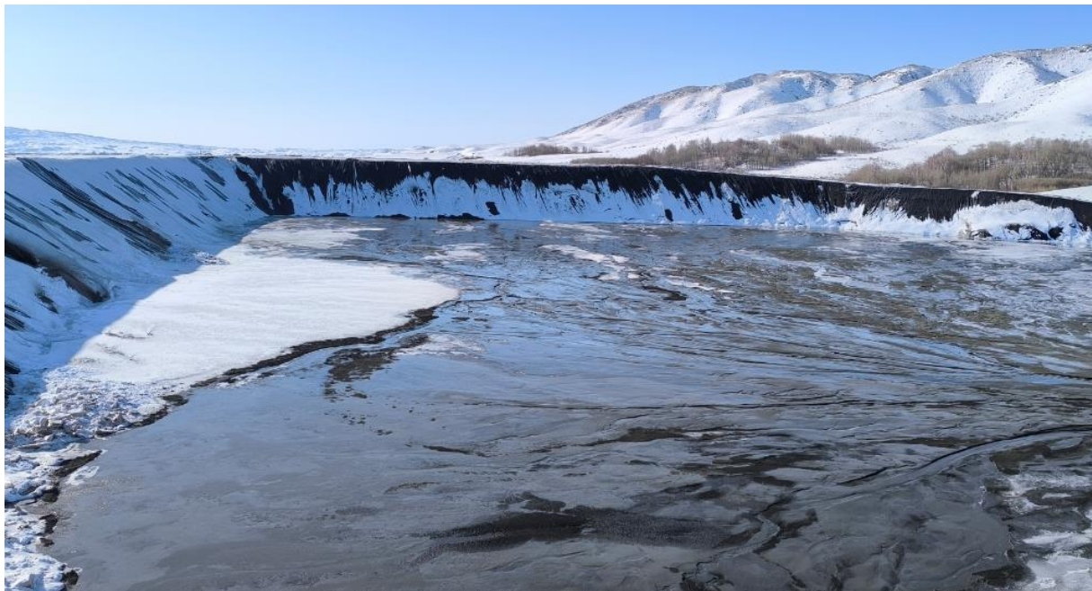
Фото 7. Вид на чашу хвостохранилища
