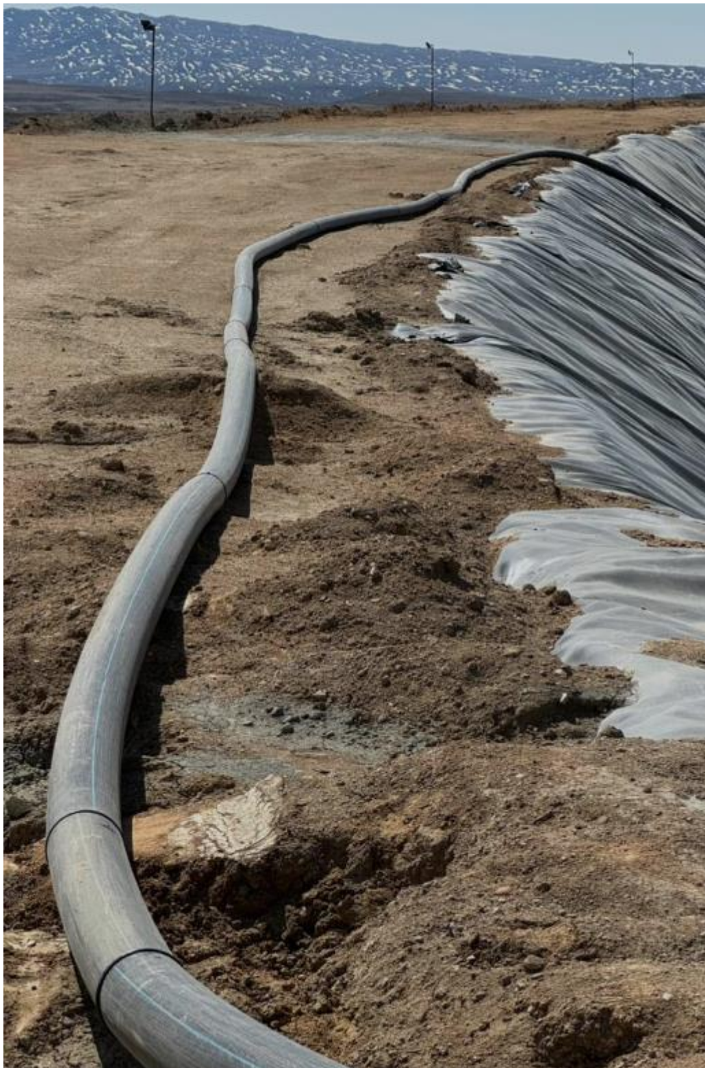
Фото 13. Распределительные пульповоды на гребне дамбы
