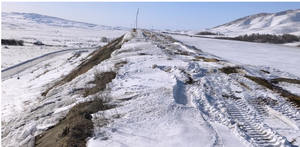
Фото 4. Вид на гребень дамбы, верховой и низовой откос
