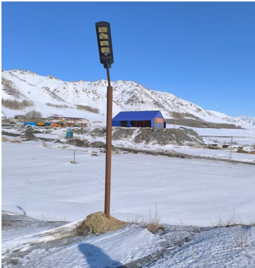
Фото 3. Опора освещения на гребне дамбы
