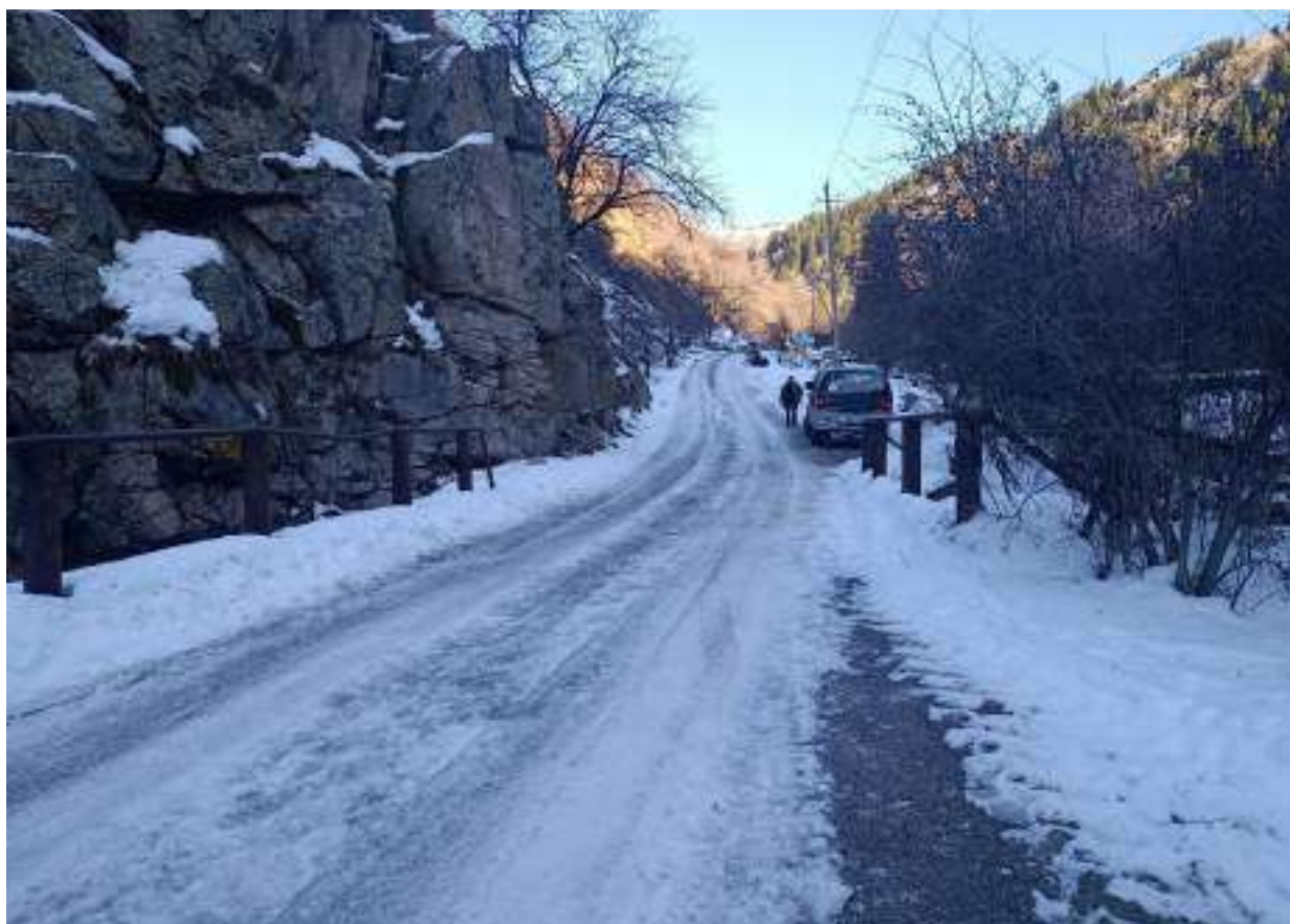
Проезжая часть моста
