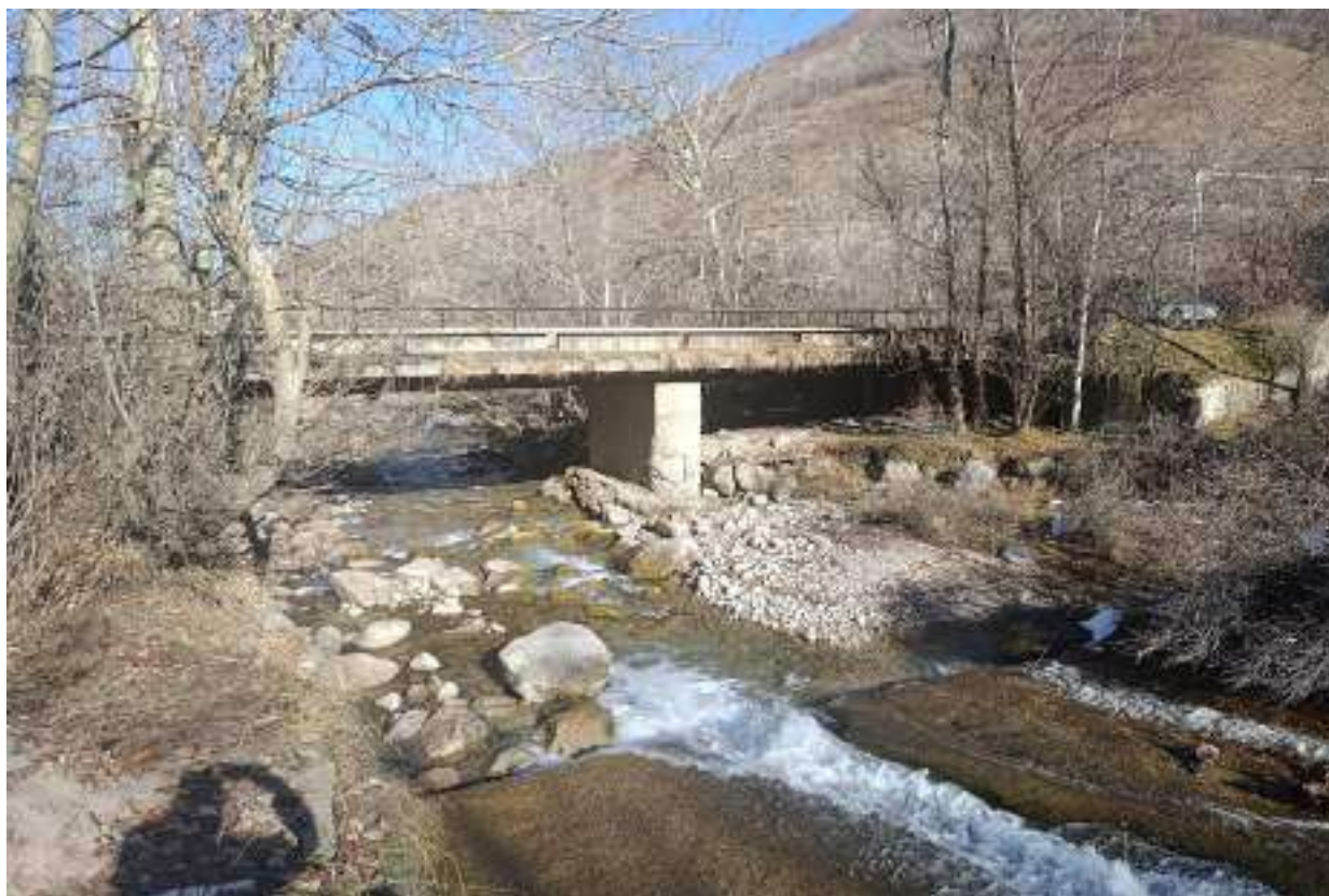
Вид на мост с верховой стороны
