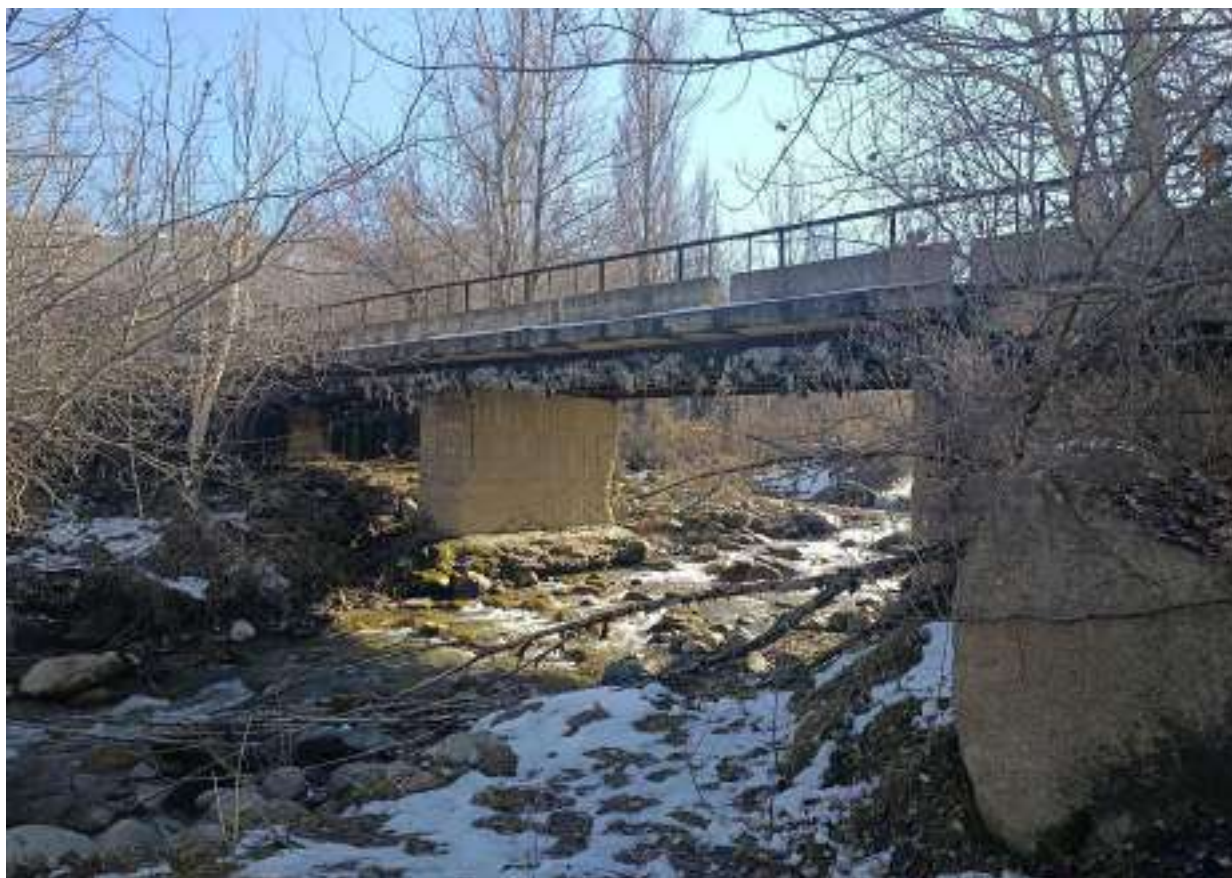
Вид на мост с низовой стороны
