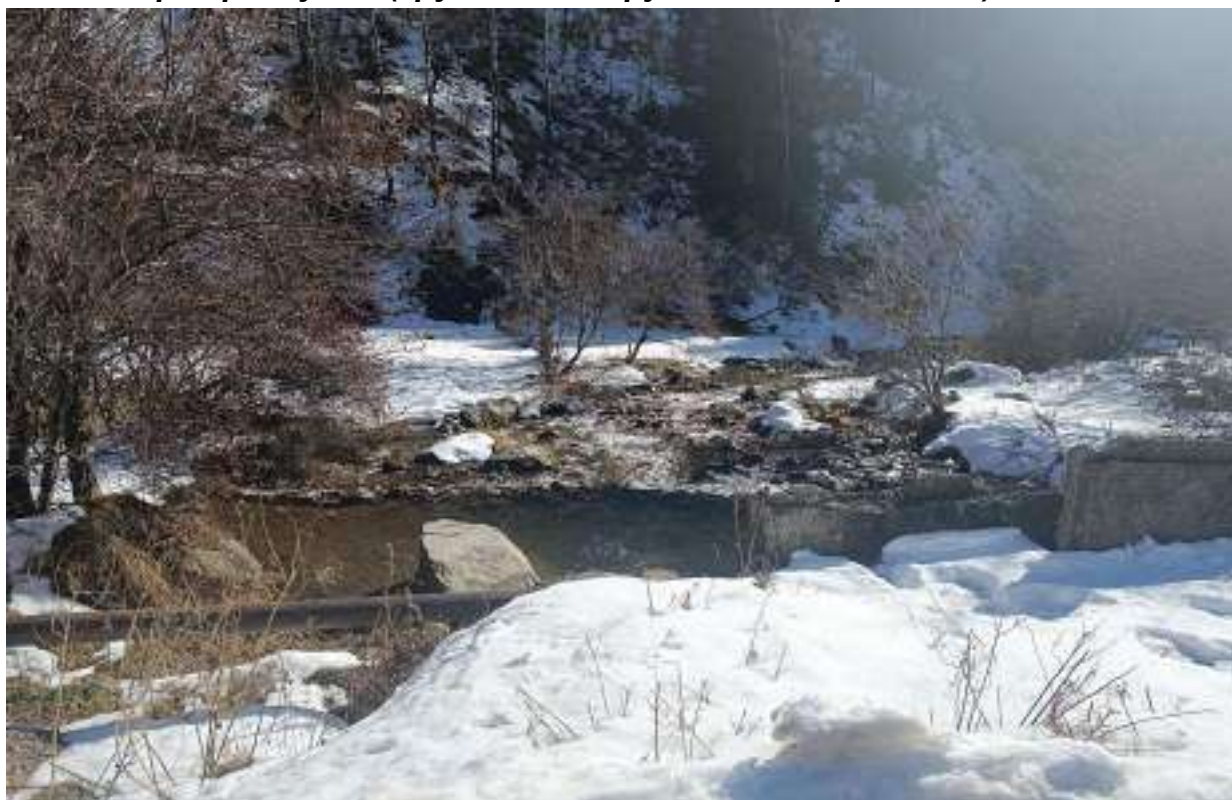
Русло реки ниже сооружения
