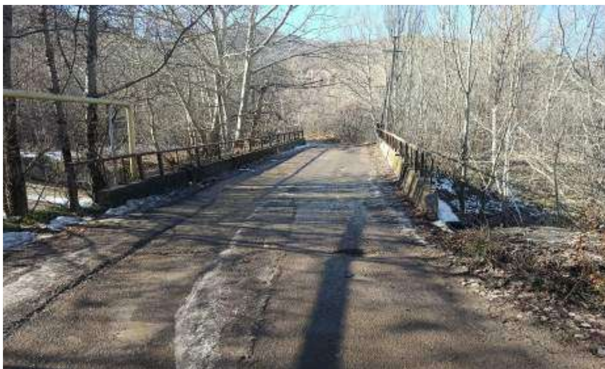
Проезжая часть моста
