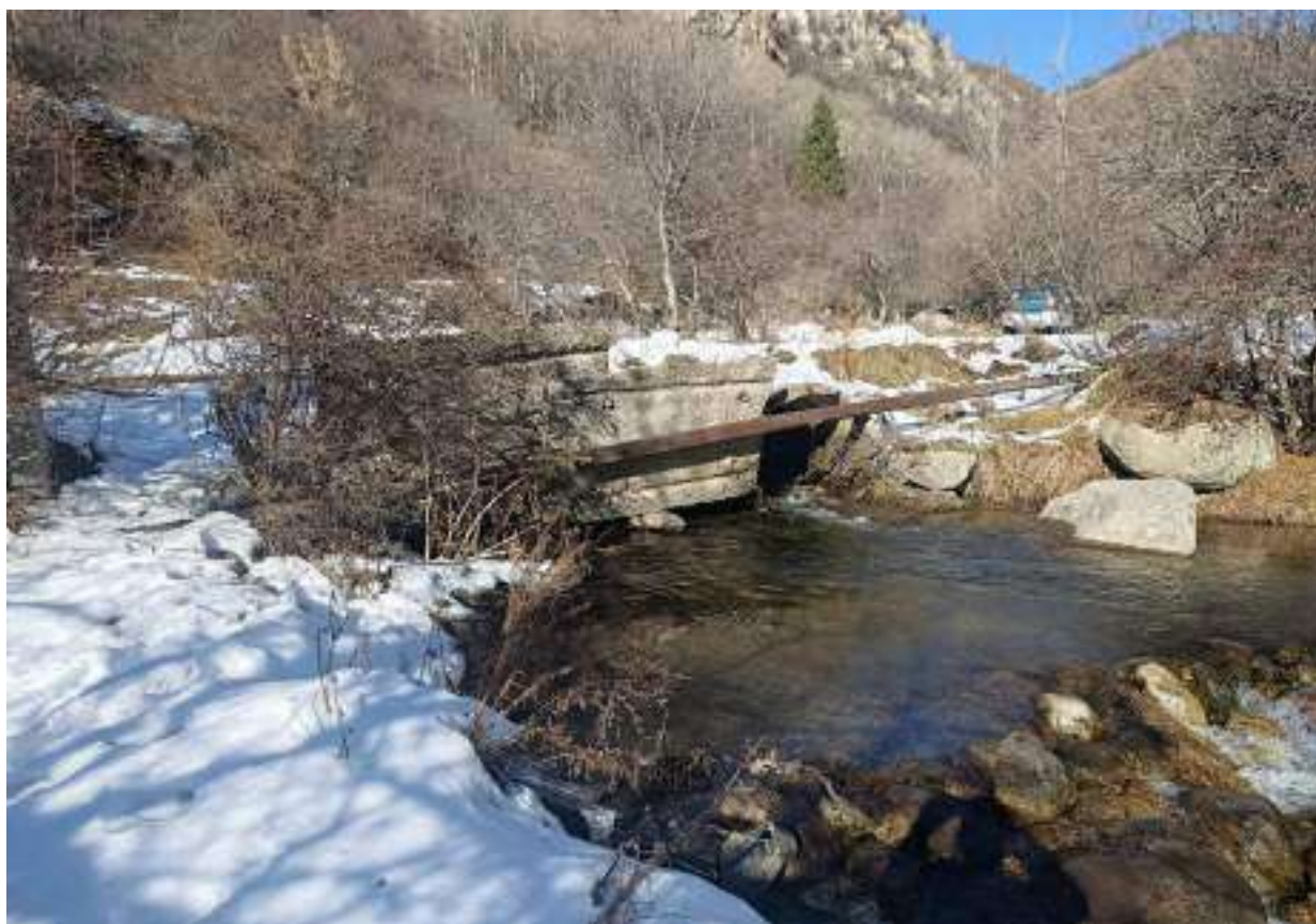
Вид на трубу с низовой стороны
