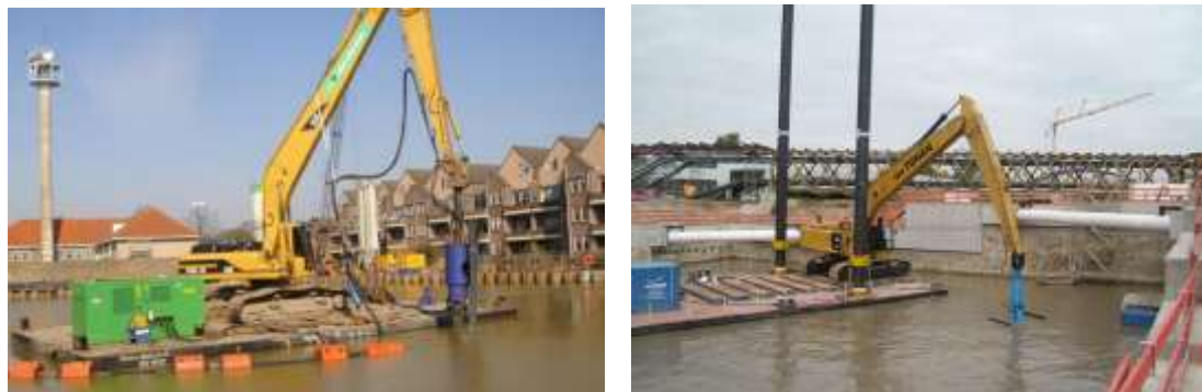
Рис. 3.1.5 Экскаватор на понтоне, оборудованный ПРН (слева) или грейфером (справа).
