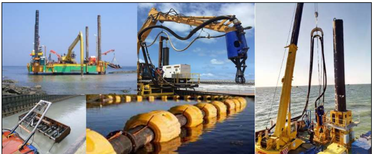
Рисунок 3.1.2 Мобильный кран на плавучей самоподнимающейся платформе с насосом DOP
