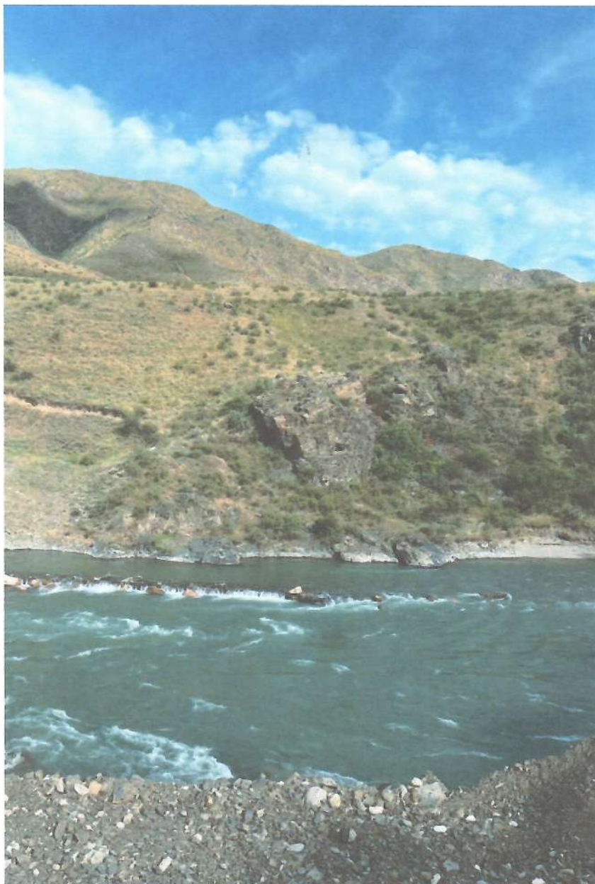
Рис 5. Нижняя часть зоны затопления плотины Верхне-Талаптинской ГЭС.
