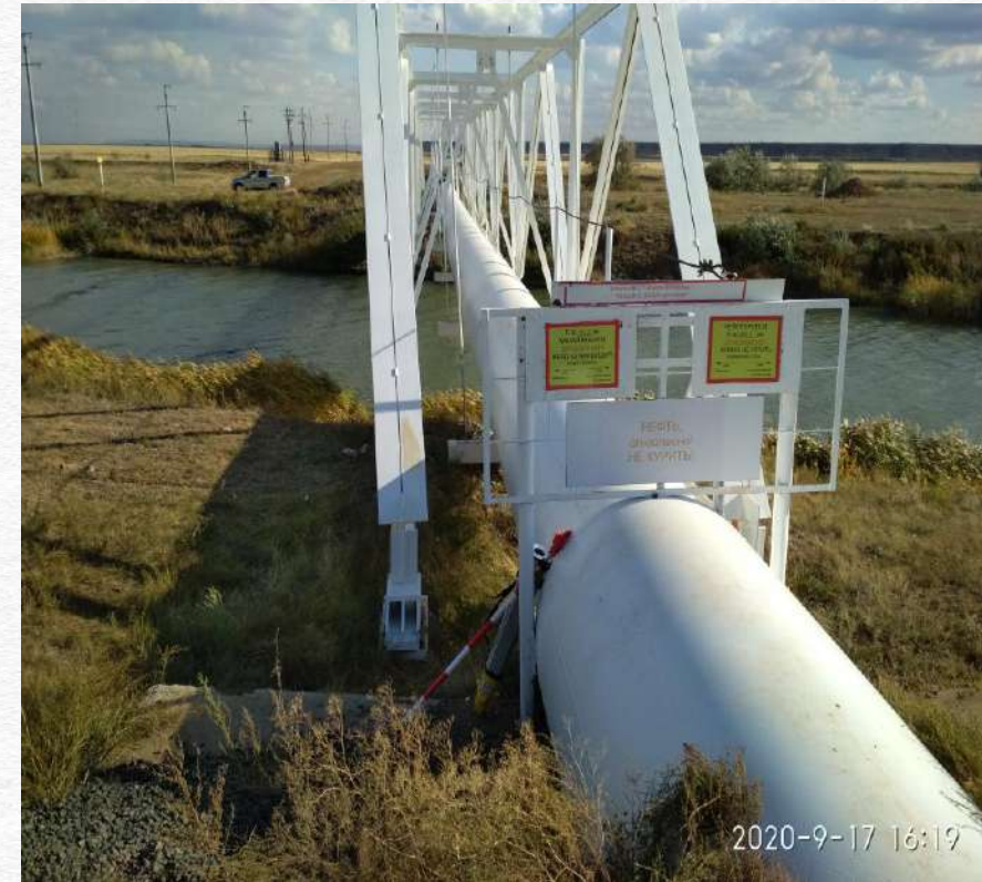
Рис. 2 Воздушный переход 148,0 км МН «Павлодар-Шымкент» \varnothing 820 мм
