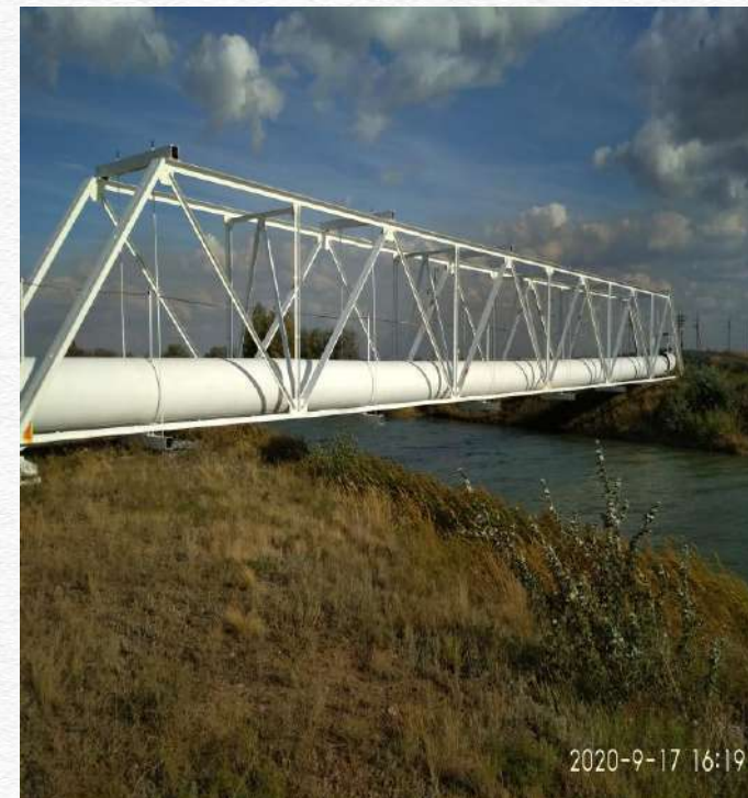
Сур. 1 "Павлодар-Шымкент» ММҚ 148 шақырымындағы Қ. Сәтпаев атындағы канал арқылы өтетін әуе өткелі
