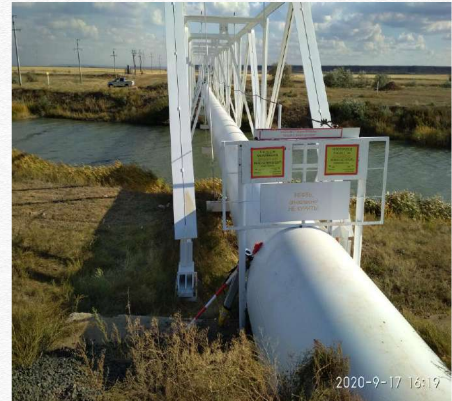
Сур. 2 "Павлодар-Шымкент" ММҚ 148 шақырымындағы Қ. Сәтпаев атындағы канал арқылы өтетін әуе өткелі
