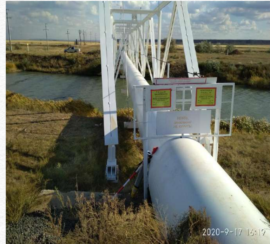
Рис. 2 Воздушный переход 148,0 км МН «Павлодар-Шымкент» \varnothing 820 мм
