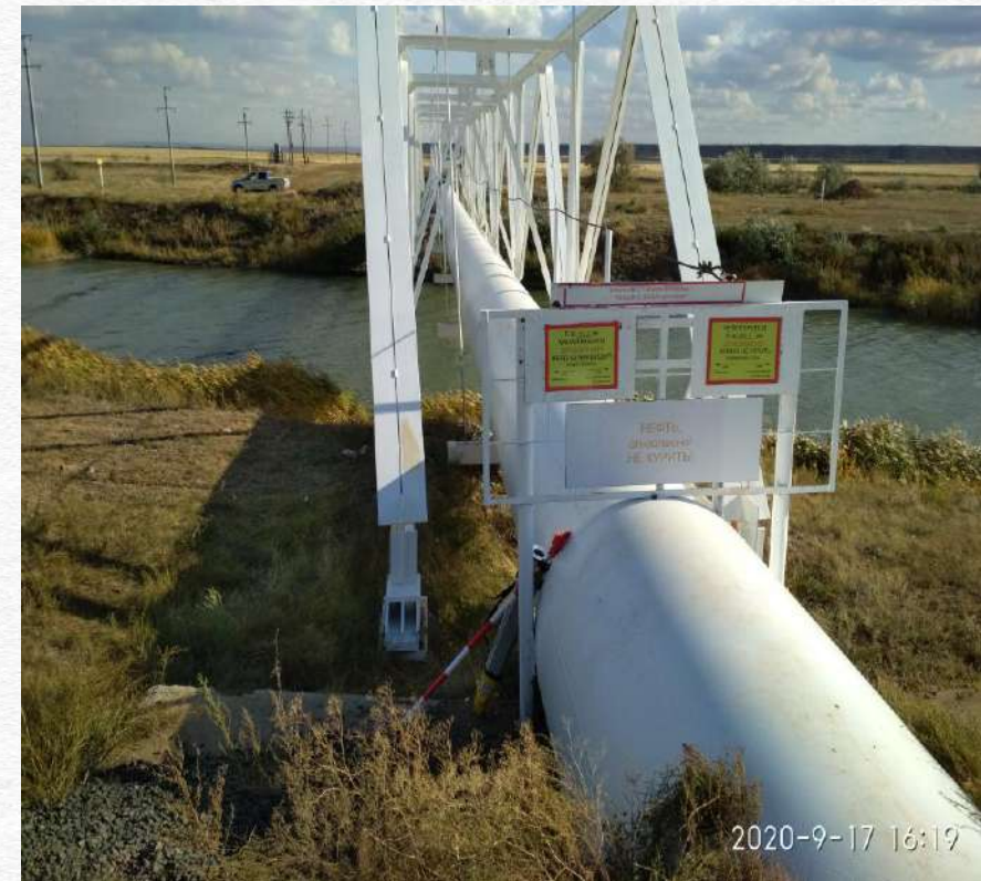
Рис. 2 Воздушный переход 148,0 км МН «Павлодар-Шымкент» \varnothing 820 мм
