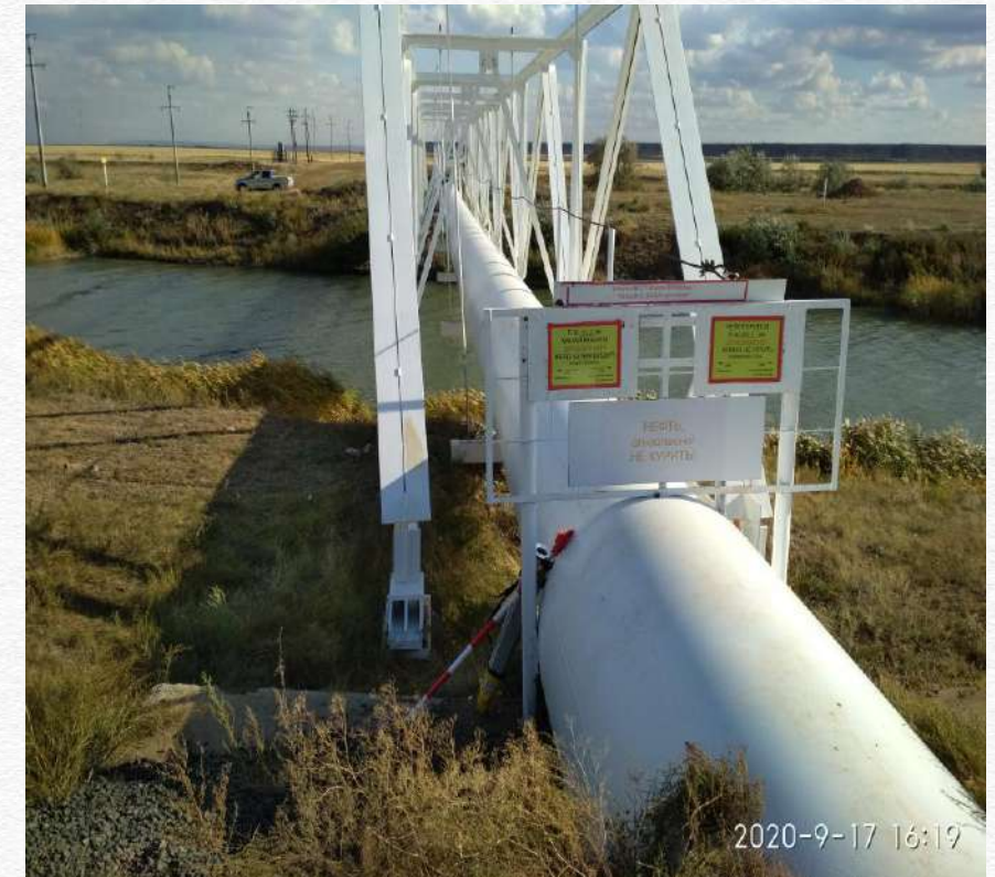
Сур. 2 "Павлодар-Шымкент" ММҚ 148 шақырымындағы Қ. Сәтпаев атындағы канал арқылы өтетін әуе өткелі
