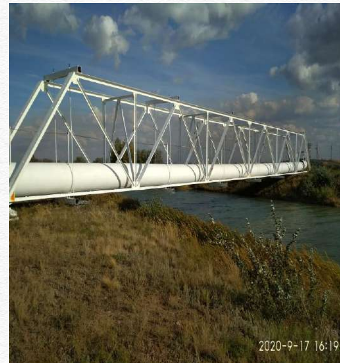
Рис. 1 Воздушный переход 148,0 км МН «Павлодар-Шымкент» Ø820мм
