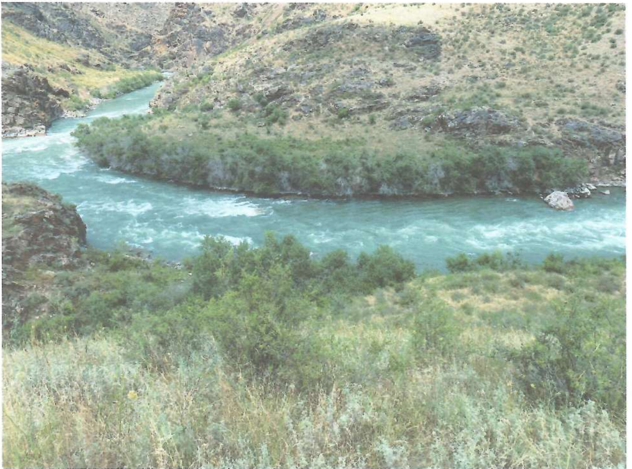
Рис 2. Верхняя часть зоны затопления плотины Верхне-Талаптинской ГЭС.
