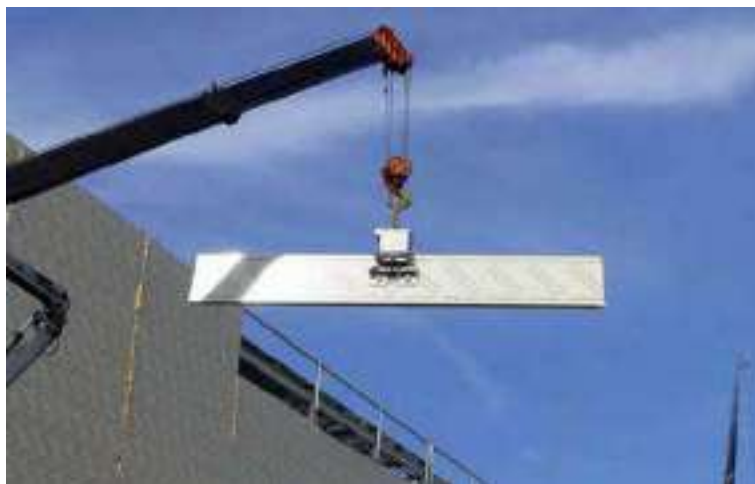
Рис. 9.7.2. Схема строповки сэндвич-панелей
