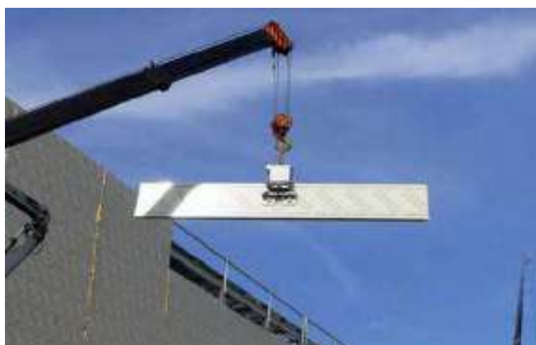
Рис. 9.8.2. Схема строповки сэндвич-панелей
