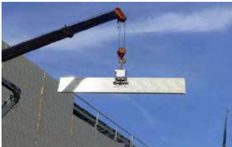
Рис. 5.9.1. Вакуумные захваты для сэндвич-панелей
