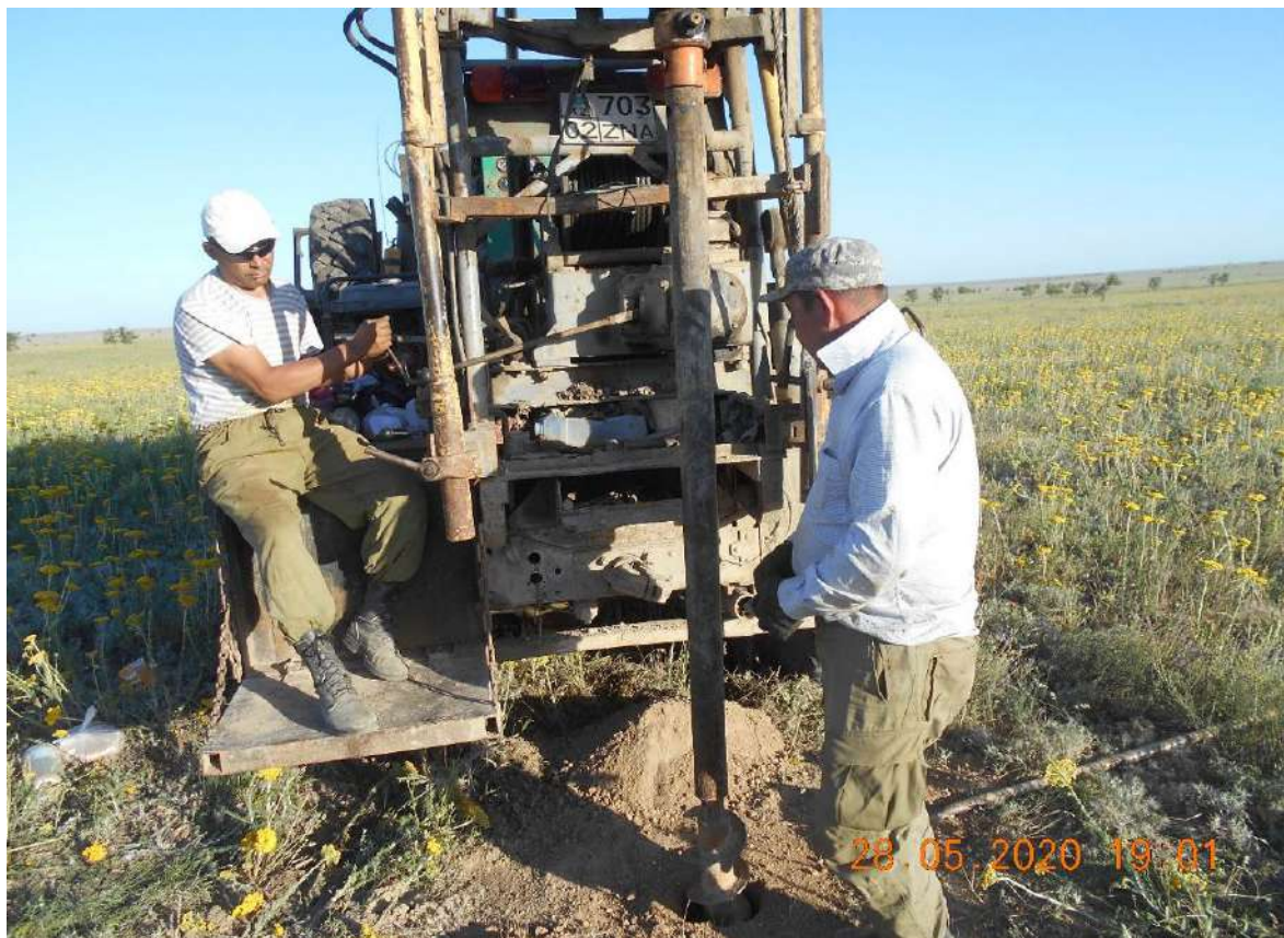
Рисунок №4 Сква. №6 Ведутся буровые работы.
