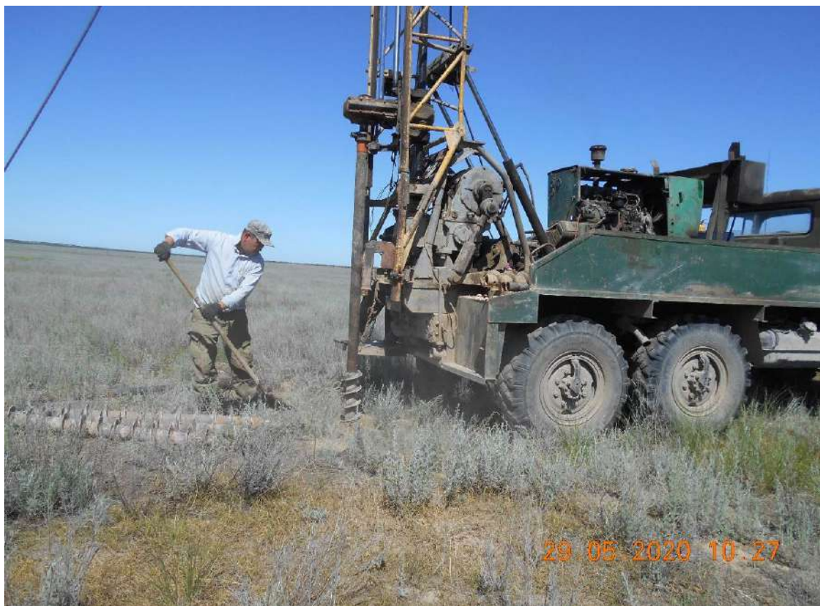
Рисунок №6 Сkv. №10 Ведутся буровые работы.
