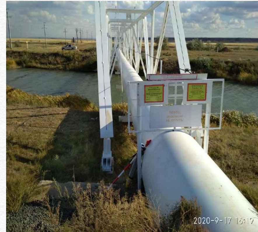
Рис. 2 Воздушный переход 148,0 км МН «Павлодар-Шымкент» \varnothing 820 мм
