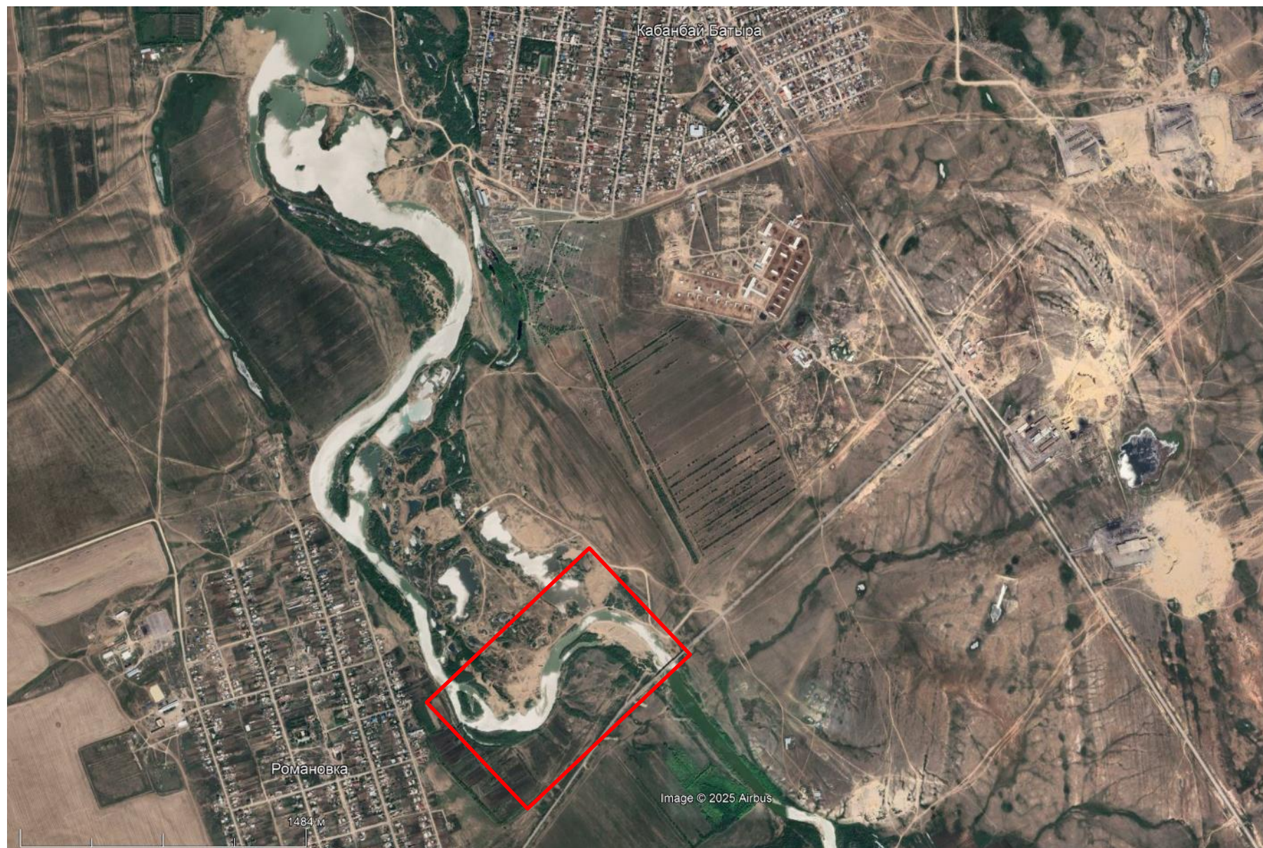
Рисунок 1.1 – Спутниковый снимок места проведения берегоукрепительных работ
