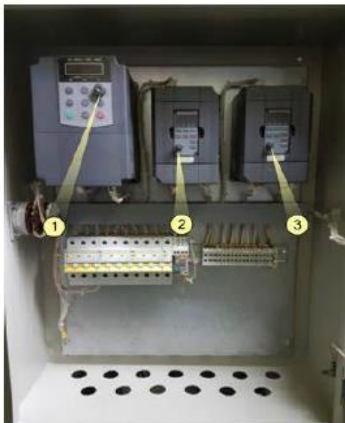
Рис. 6 Расположение внутри шкафа управления частотных преобразователей для регулировки скорости транспортёров
