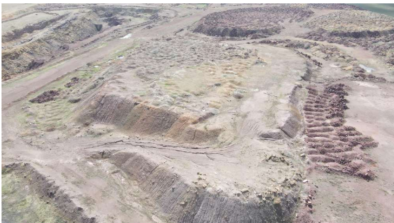
Рисунок 2.1.2 – Техногенное изменение русла реки Узынбулак — засыпка и нарушение естественного русла в результате горных работ и формирования отвалов
