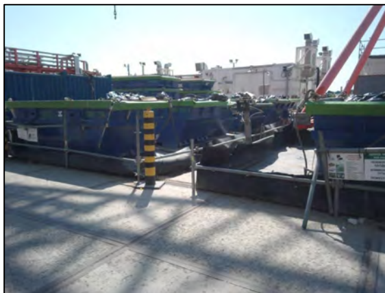
Фото 1 Площадка временного хранения отходов на острове Д
