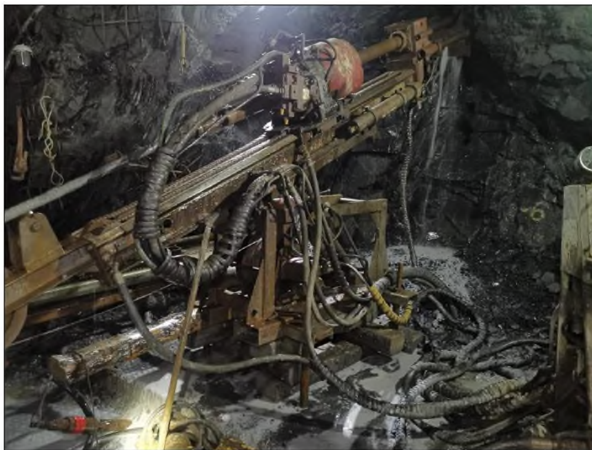
Рисунок 17. Установка Sandvik-130DE в буровой камере на месторождении Кварцитовые Горки
