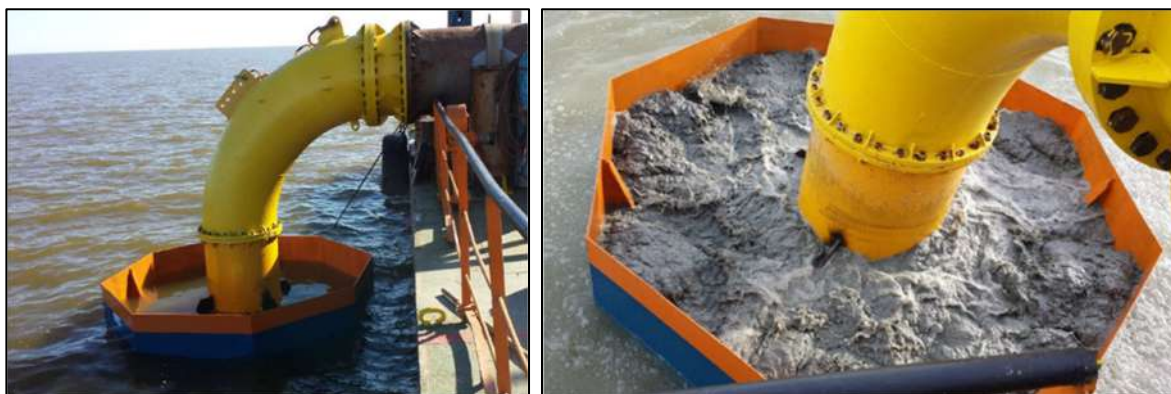
Рисунок D.3 Технология «cooking pot» для затопленного сброса пульпы в море
