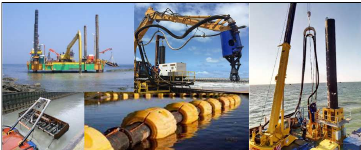
Рисунок 3.6 Мобильный кран на плавучей самоподнимающейся платформе с насосом DOP
