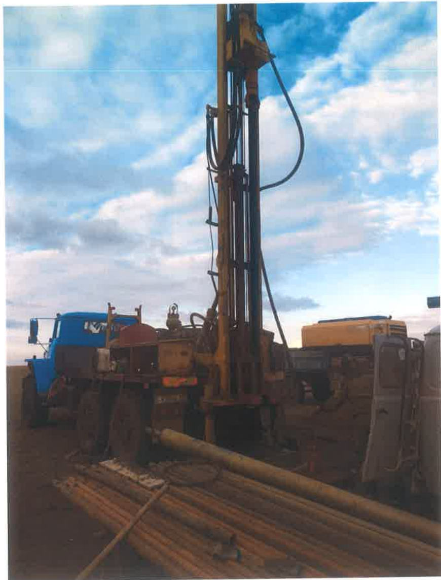
Процесс бурения скважины 1-р, буровой установкой
