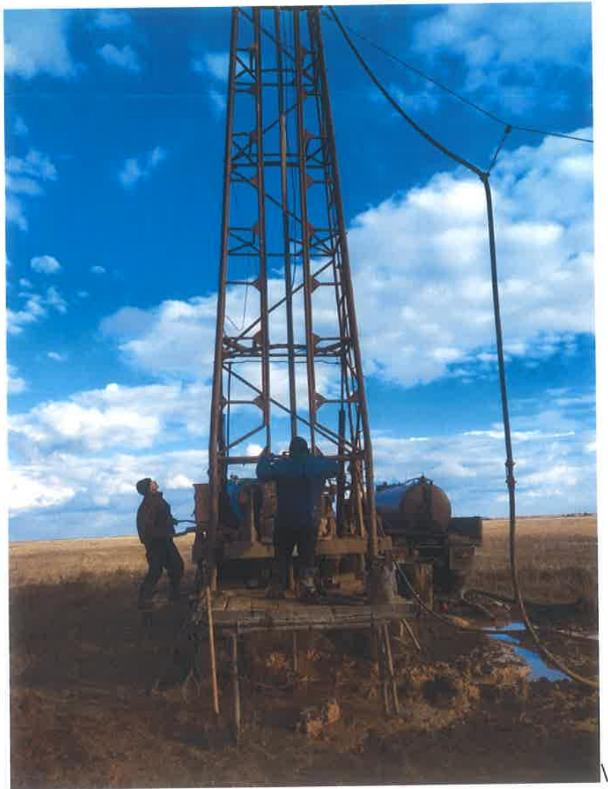
Процесс бурения скважины №124
