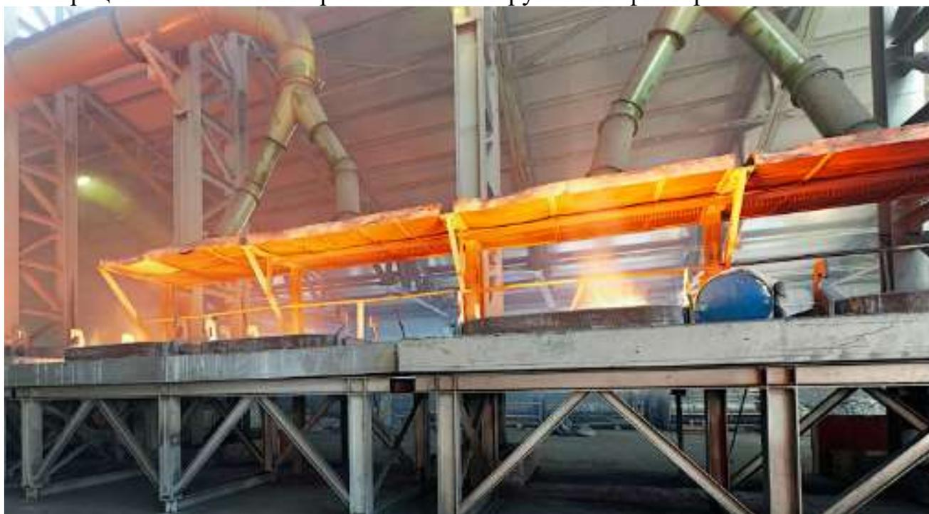
Рис. 16- Система аспирации очистки воздуха
