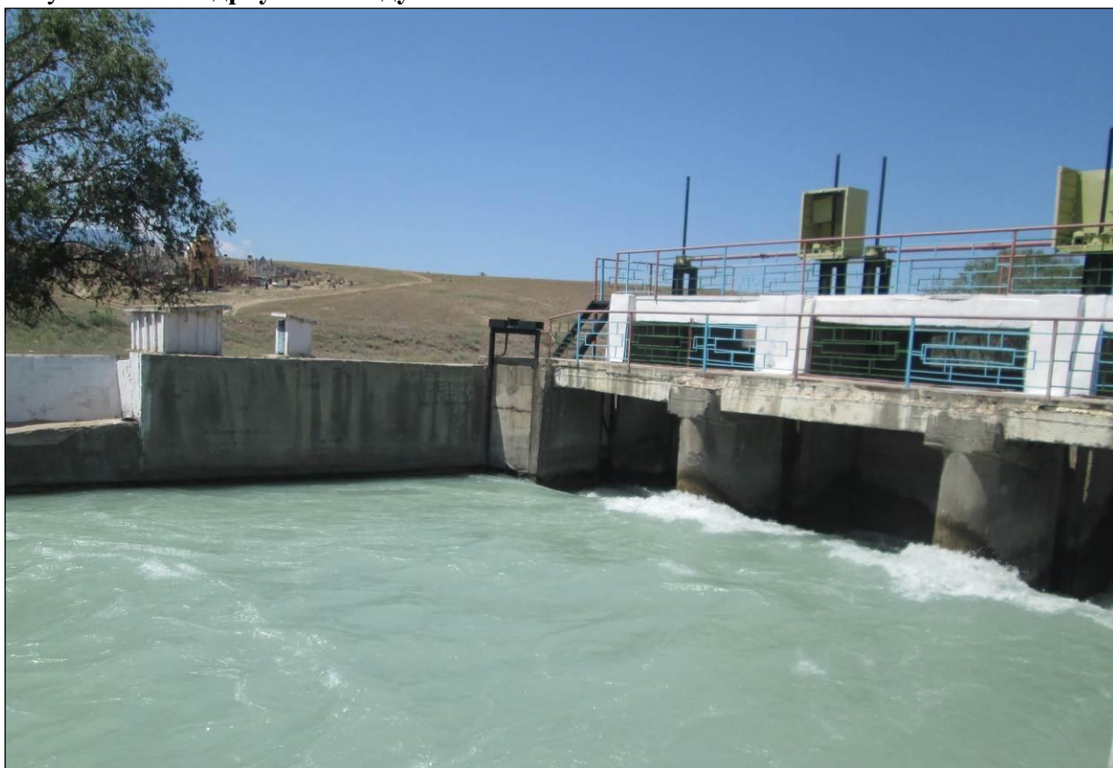
Рисунок 1.6 – Водовыпуск на оросительные каналы
