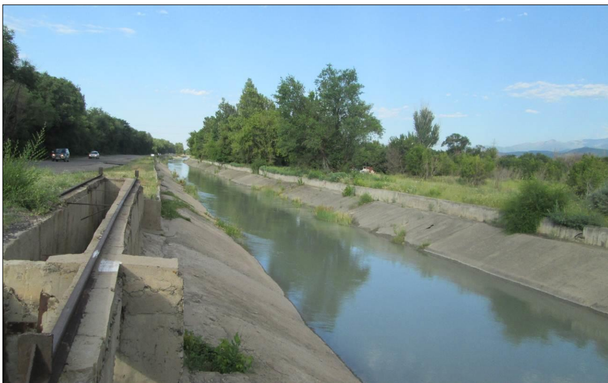
Рисунок 1.8 – Дно и стенки канала забетонированы (ПК 110)
