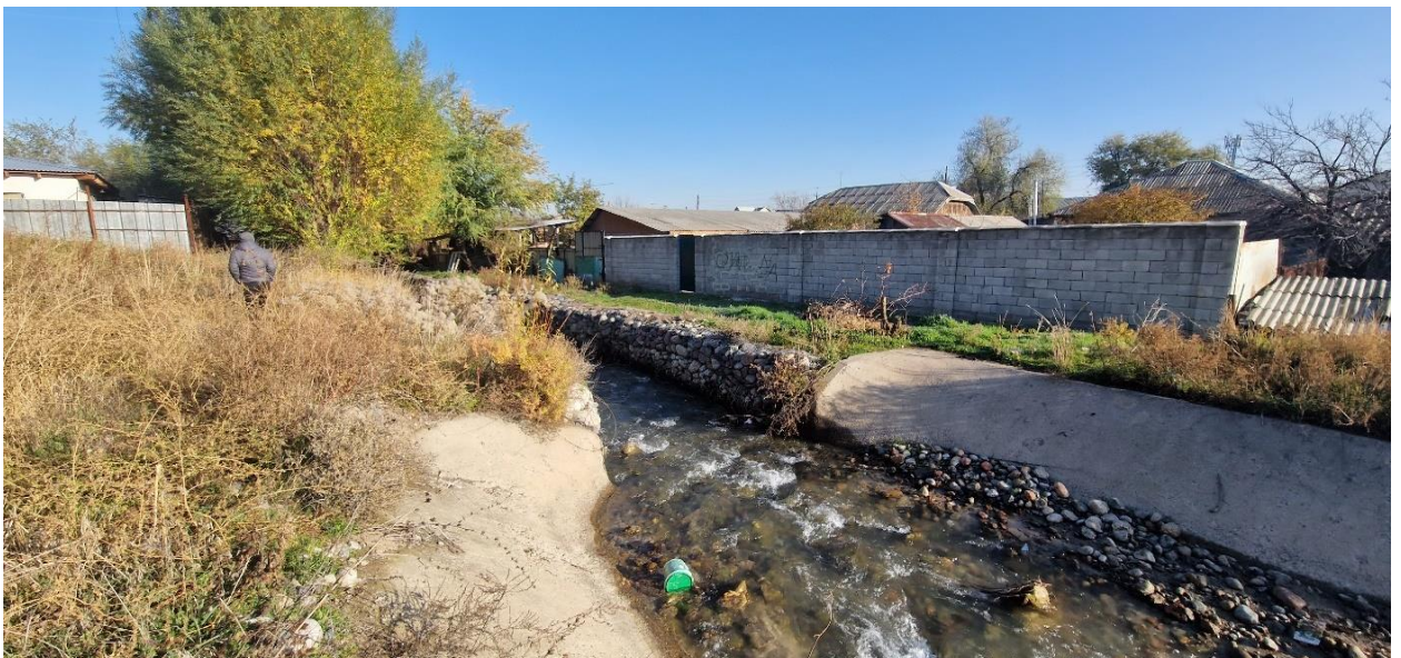
Фото 8. Начало крепления участка из габионов
