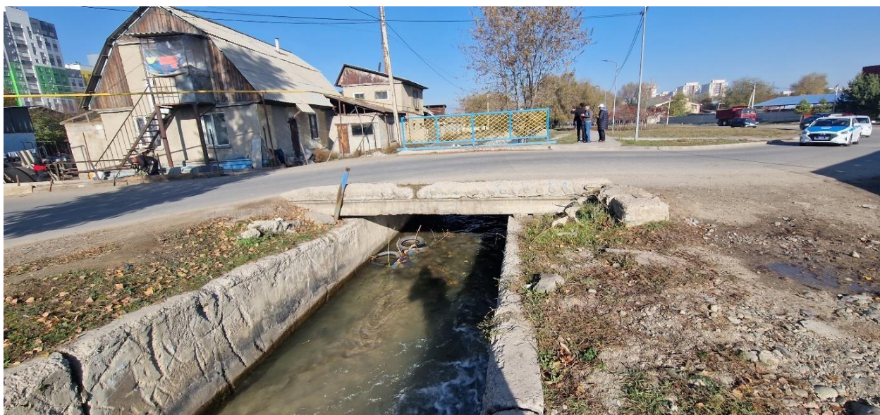
Фото 10. Мостовое сооружение через реку по ул. Аханова
