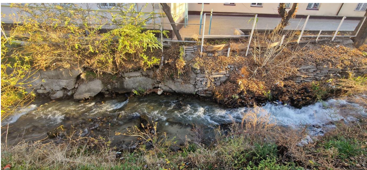
Фото 2. Разрушенное крепление
