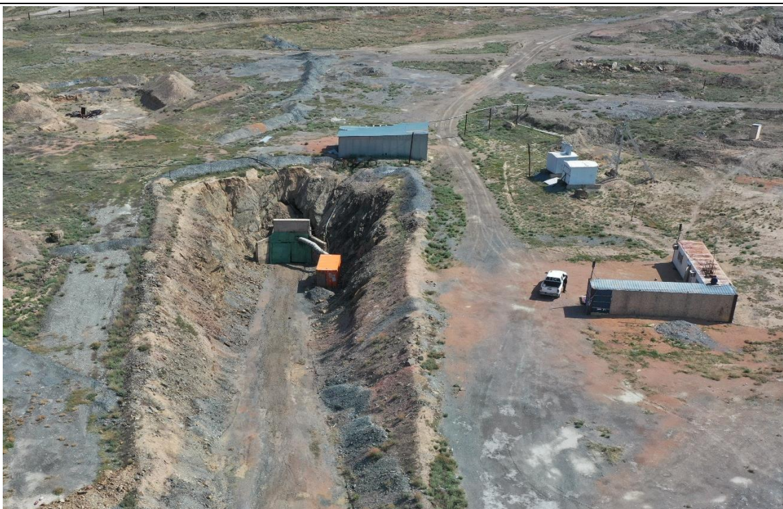
Рисунок 3 – Портал НТС, контейнеры, подстанция
