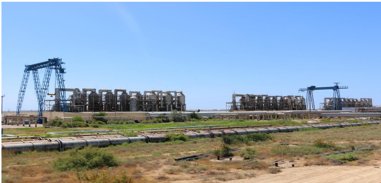
Рис. 6.2.1 Подача морской воды на опреснительные установки осуществляется насосной станцией по водопроводам.
