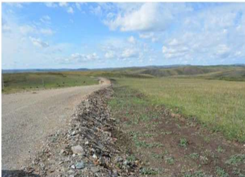
Фото 4. Отсыпанный участок дороги.
