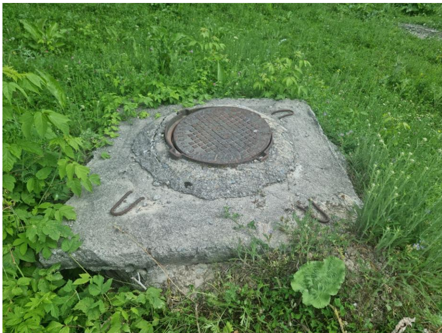
Рисунок 4. Каптаж.
