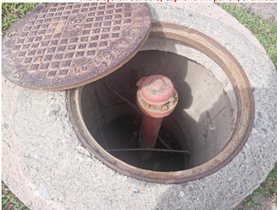
Рисунок 7. Пожарный гидрант.
