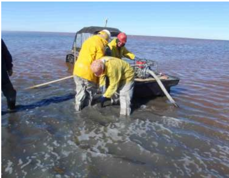
Рисунок 7 - Установка гидромониторного бурения
