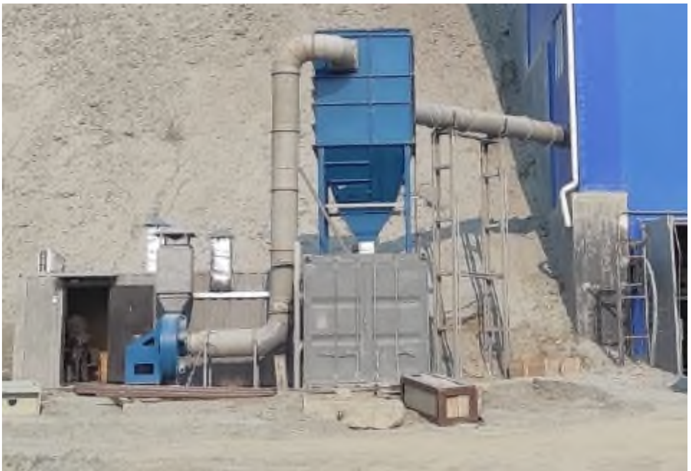
Пример расположения контейнера для пыли и контейнера для компрессора и системы управления (справа налево)
