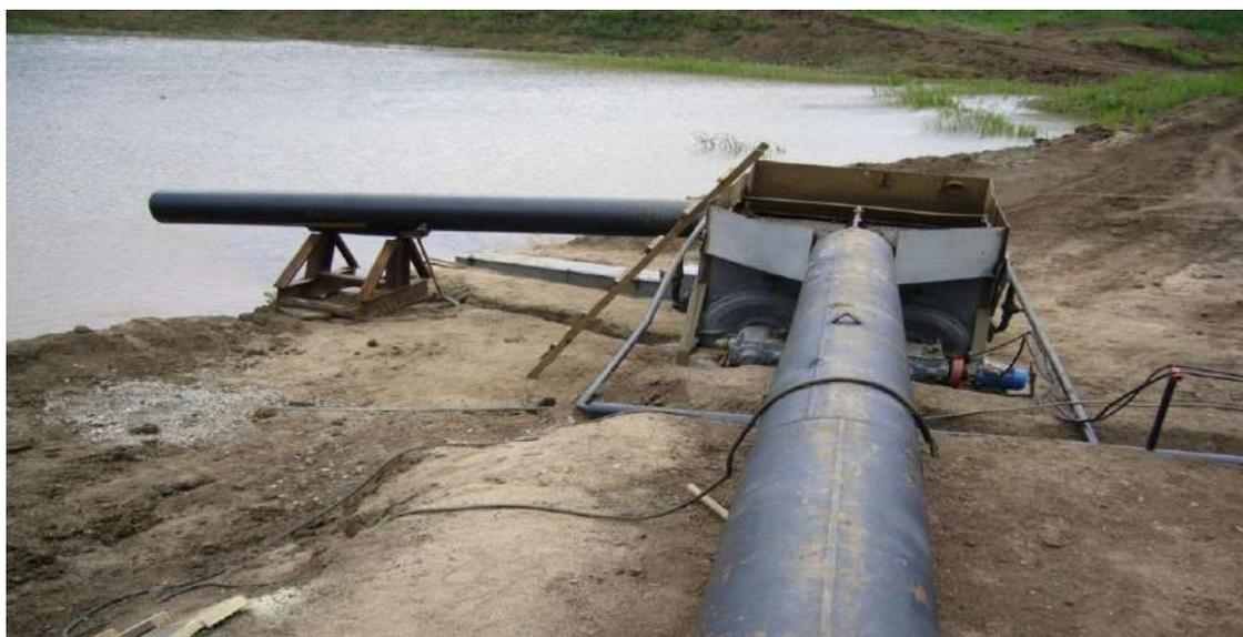
*Узлы промывочного прибора ПГШ - 60/2Б.*
