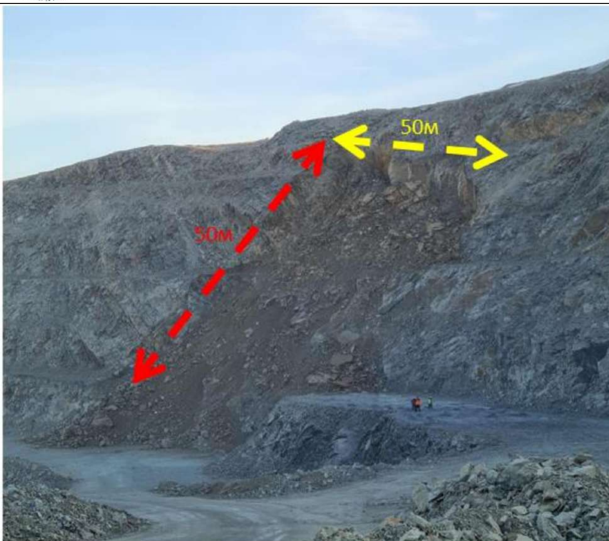
Рисунок 5 – Обрушения в восточной части карьера Пустынное 15.02.2021
