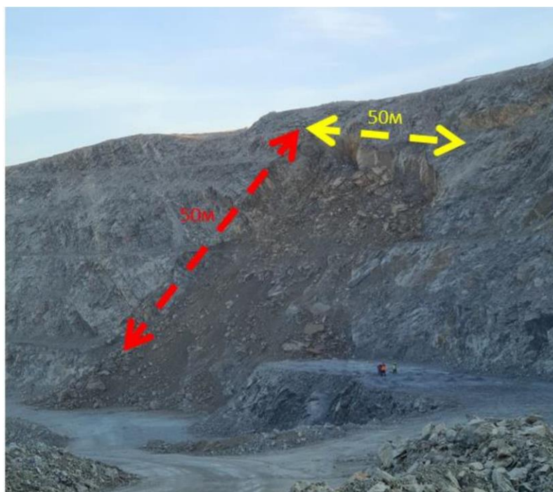
Рисунок 2.8 - Обрушения в восточной части карьера Пустынное 15.02.2021
