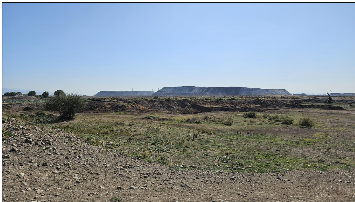
Рисунок 4.2 – Вид на участок строительства с северной стороны
