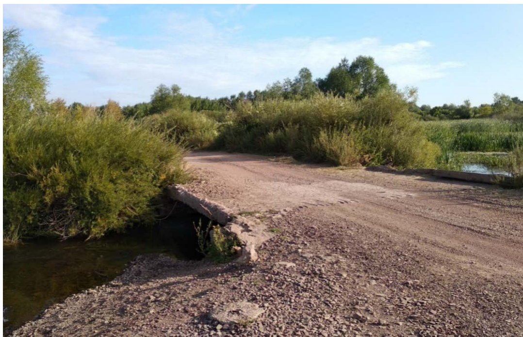
Рис. 3.1 Искусственное сужение русла реки при строительстве автомобильного переезда через р. Колутон. ПК 23+30
