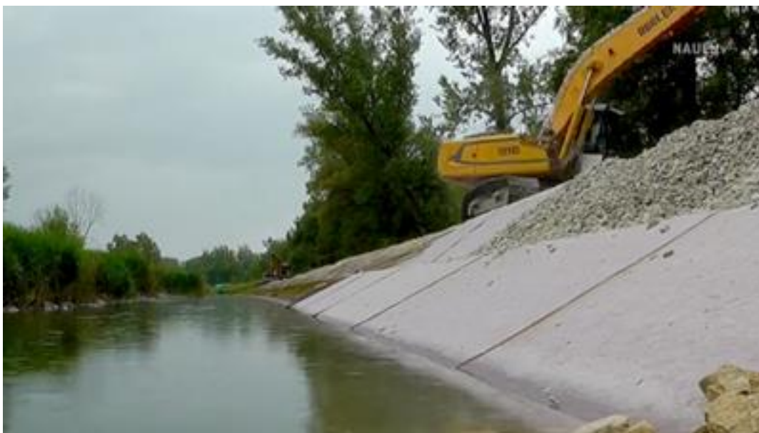
Рисунок 8.6.1 Пример укладки бентонитового полотна. Укладка бентомата в существующей дамбе (без остановки воды и турбин)
