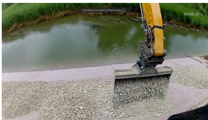
Рисунок 8.6.3 Крепление по верху бентомата.
