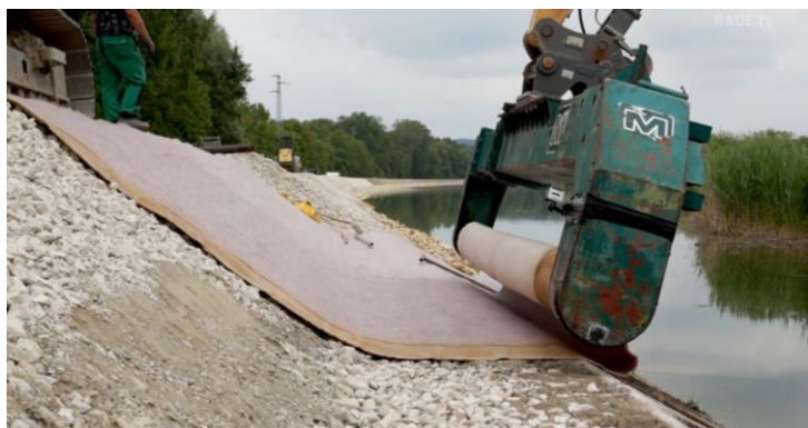
Рисунок 8.6.2 Пример укладки бентонитового полотна.
