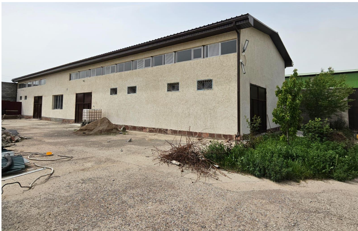
Рисунок 2. Фотография цеха по утилизации отходов на промплощадке №2 ТОО «УтилСервис»
