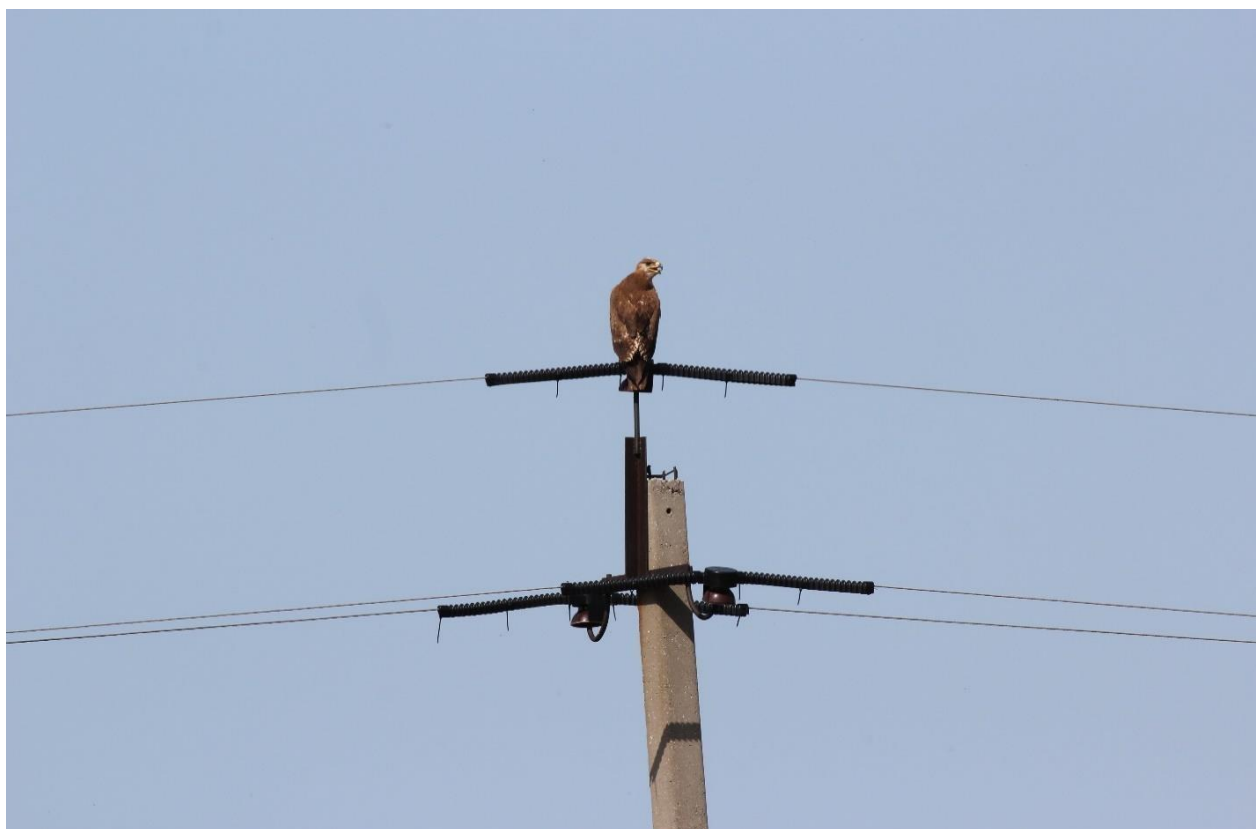
Рис. 16. Пример птицевзащитных устройств на ЛЭП
