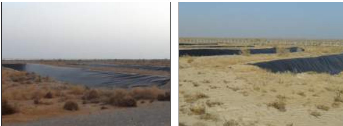
Рисунок 2.3 - Гидроизоляционное покрытие карт полимерной пленкой
