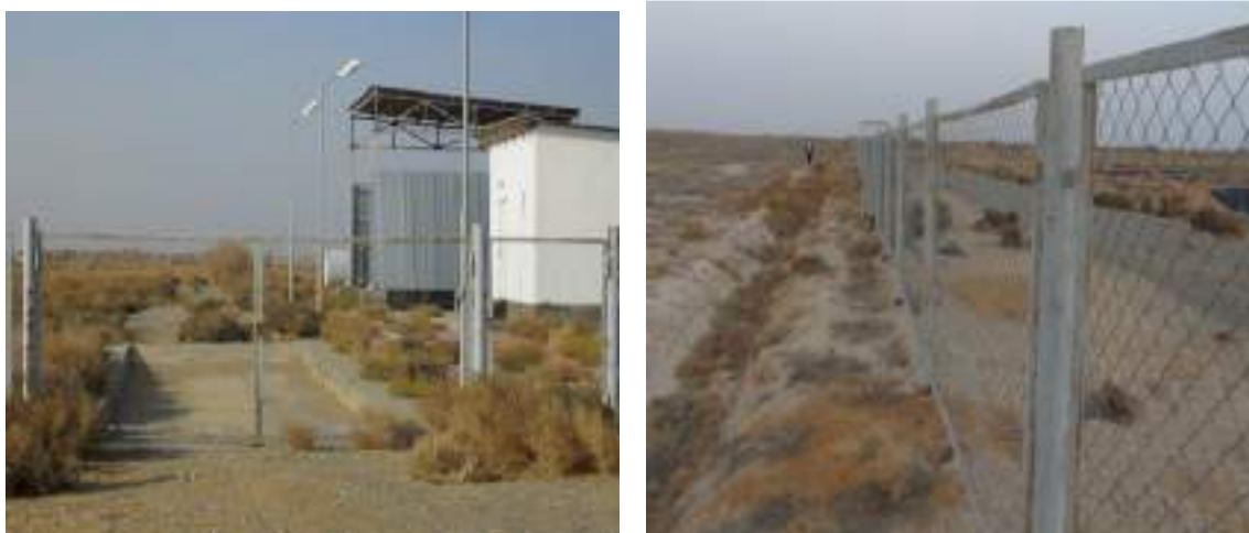
Рисунок 3.2 - Элементы полигона: ограждение, инженерные сооружения, хозяйственная зона, коммуникации и подъездные дороги
