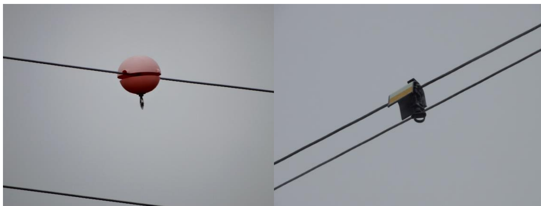
Рис. 1 . Пример маркирующих устройств, предотвращающих столкновение птиц об провода.
