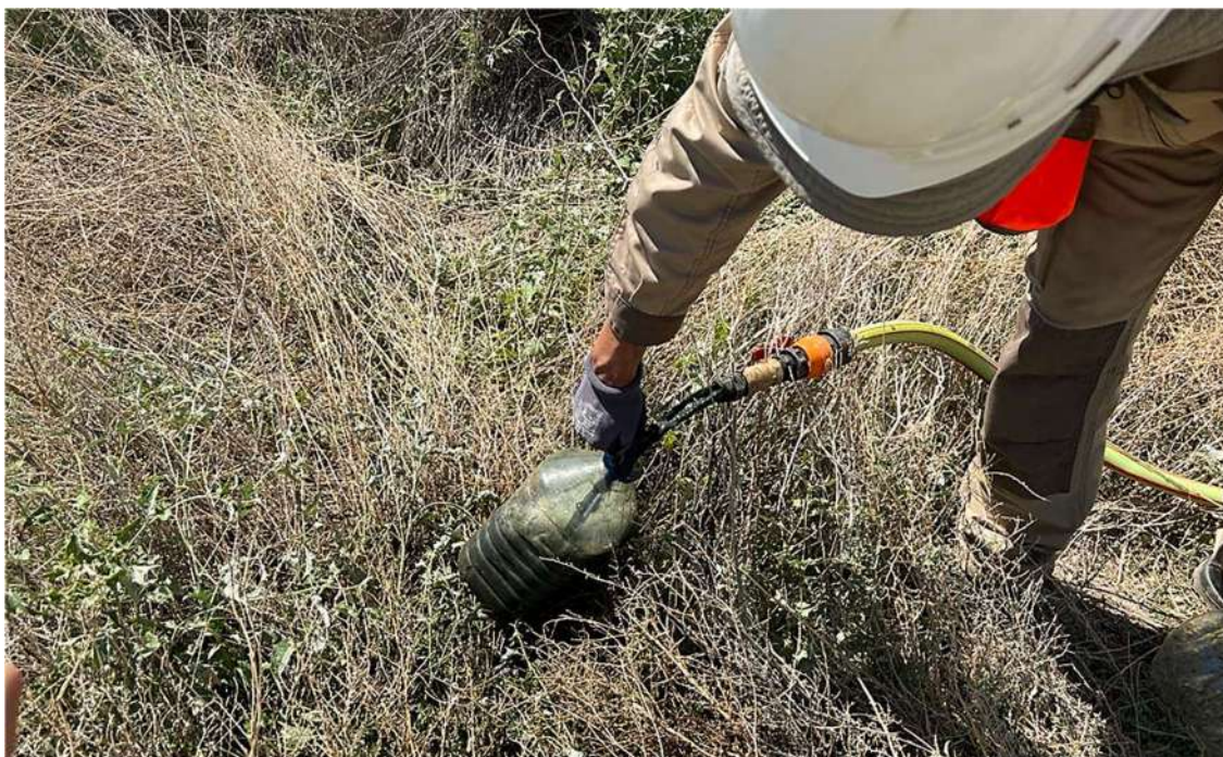
Рисунок 6.5 – Прокачка скважины № 212сн
