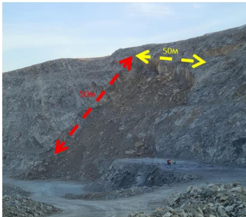
Рисунок 2.8 - Обрушения в восточной части карьера Пустынное 15.02.2021
